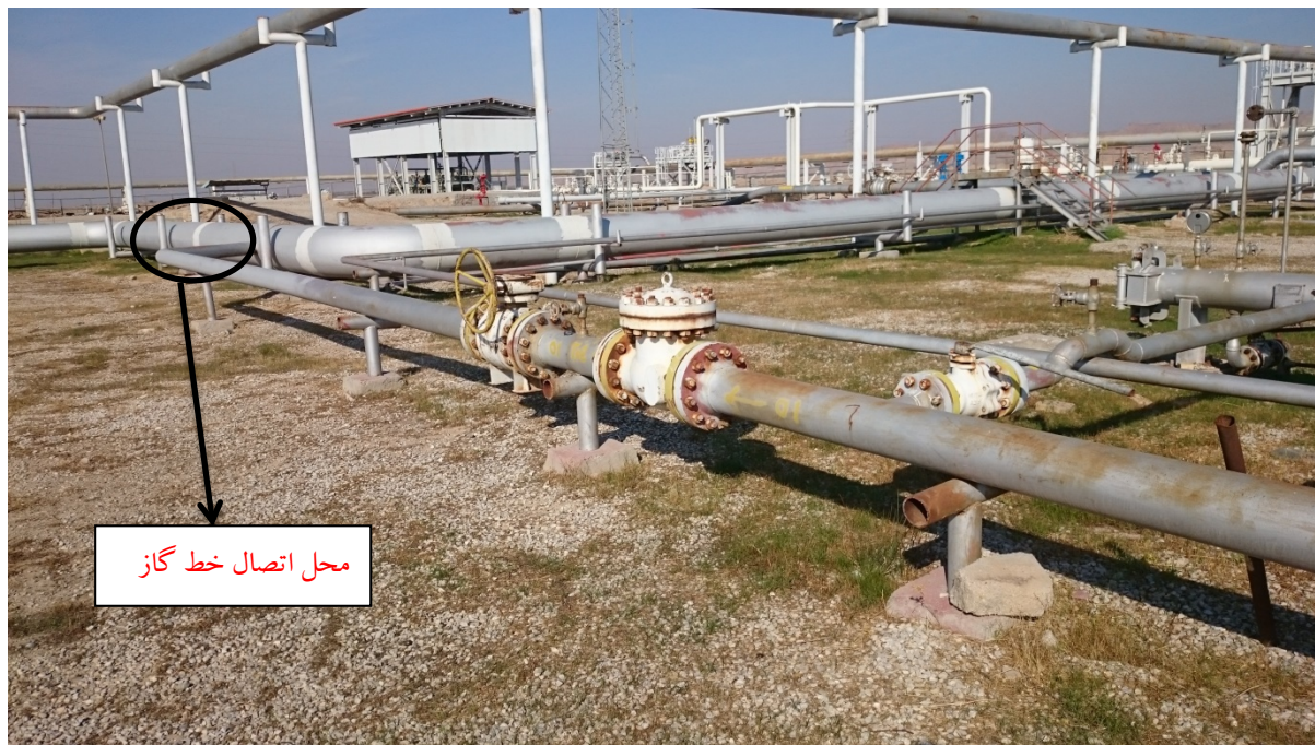
محل اتصال خط گاز دریافتی به خطوط ایستگاه
