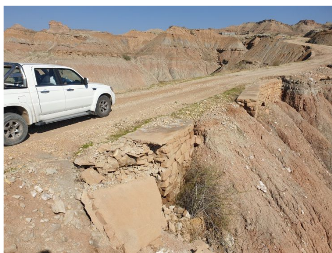
وضعیت نامناسب و تخریب دیوار سنگی
