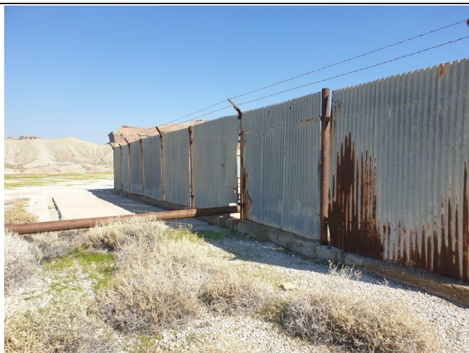
نمایی از فنس و بتن زیر آن و محل خروج خط لوله جریانی
