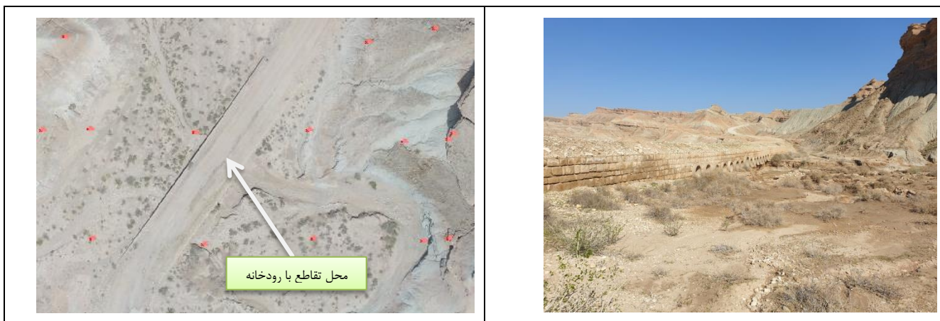
محل تقاطع جاده دسترسی با رودخانه و تعدد کالورتهای لوله ای در کیلومتر ۳+۵۰۰
