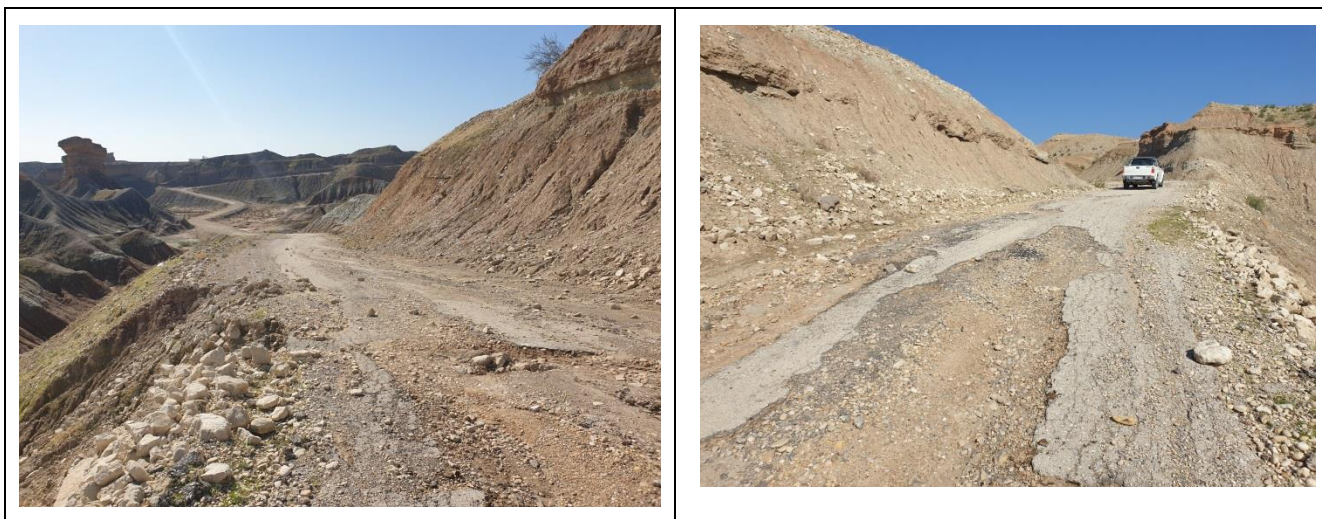
نماهایی از محدوده های آسفالتی تخریب شده ی جاده دسترسی
