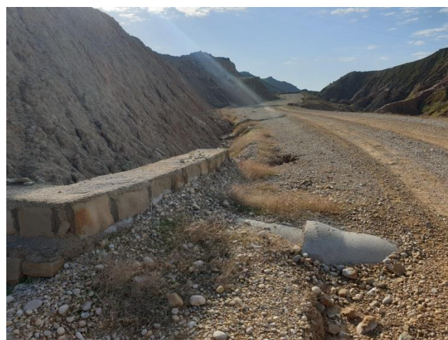
آب شستگی جاده و نمایان شدن فارسیت
