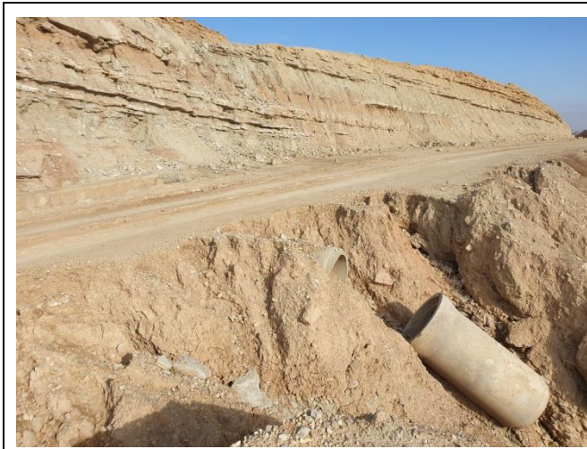
تخریب سازه تخلیه
