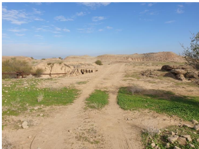
جاده دسترسی لوله گودال سوخت (که دچار آبشستگی شده است)
