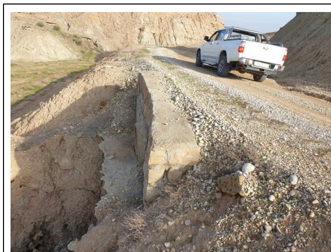
آب شستگی زیر سنگ چینی کالورت
