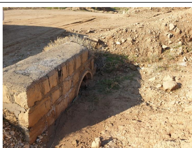
تخریب بخشی از سنگ چینی و انباشت رسوبات
