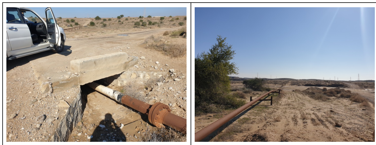
خط لوله نفت روزمینی و محل تقاطع با جاده دسترسی (کیلومتر 0+850)
