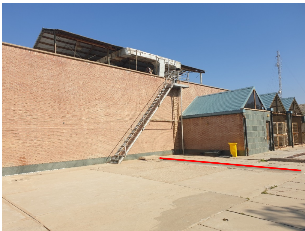
فضای ترانسفورمرهای جدید (مسیر کانال کابل ها با خط قرمز مشخص گردیده - پله دسترسی به بام).
