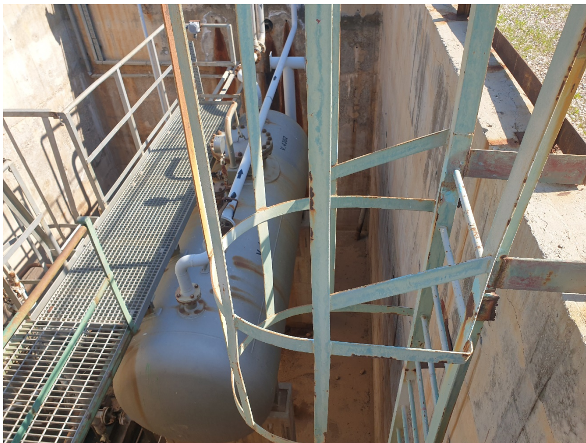
مخزن استوانه‌ای Closed drain
