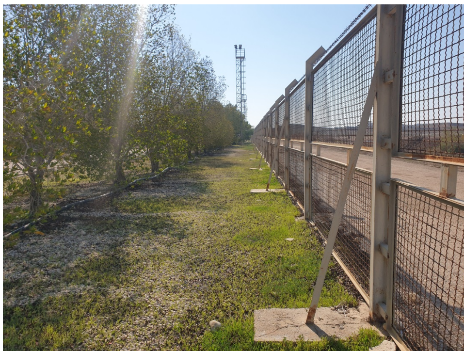
بخشی از فنس که برای عبور خط لوله 8 اینچی نیاز به بازشو دارد (سمت غربی)
