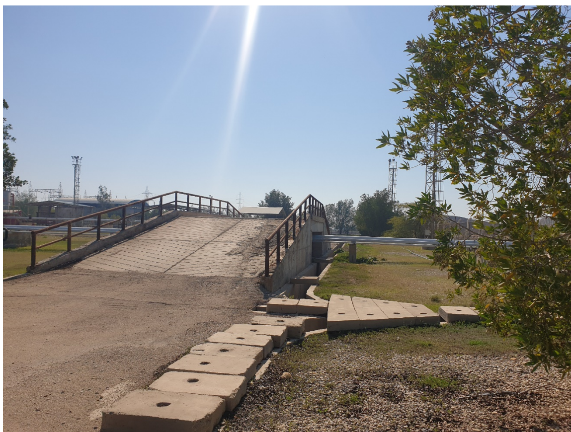
خروجی انتهایی به سمت حوضچه تبخیر در حال احداث
