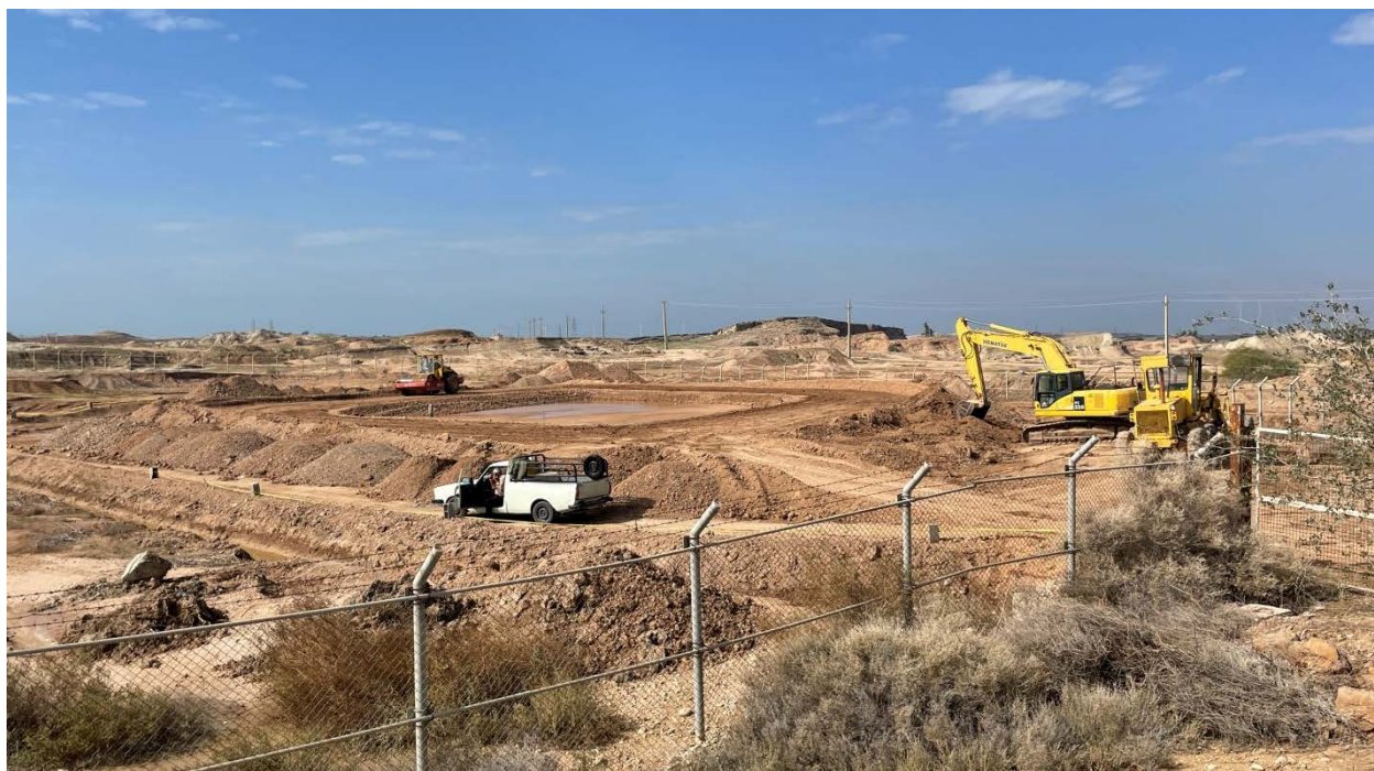
حوضچه تبخیر در حال احداث
