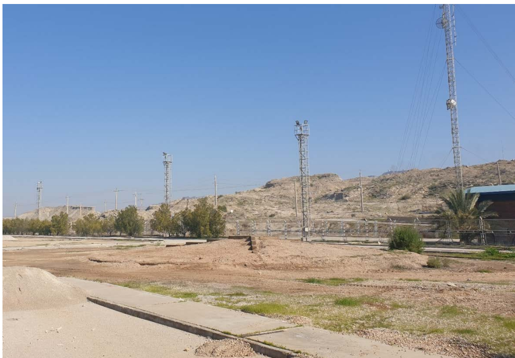
محل اتاق کنترل (وجود خاکریزی و بتن ریزی میدان پیشین قابل مشاهده است).
