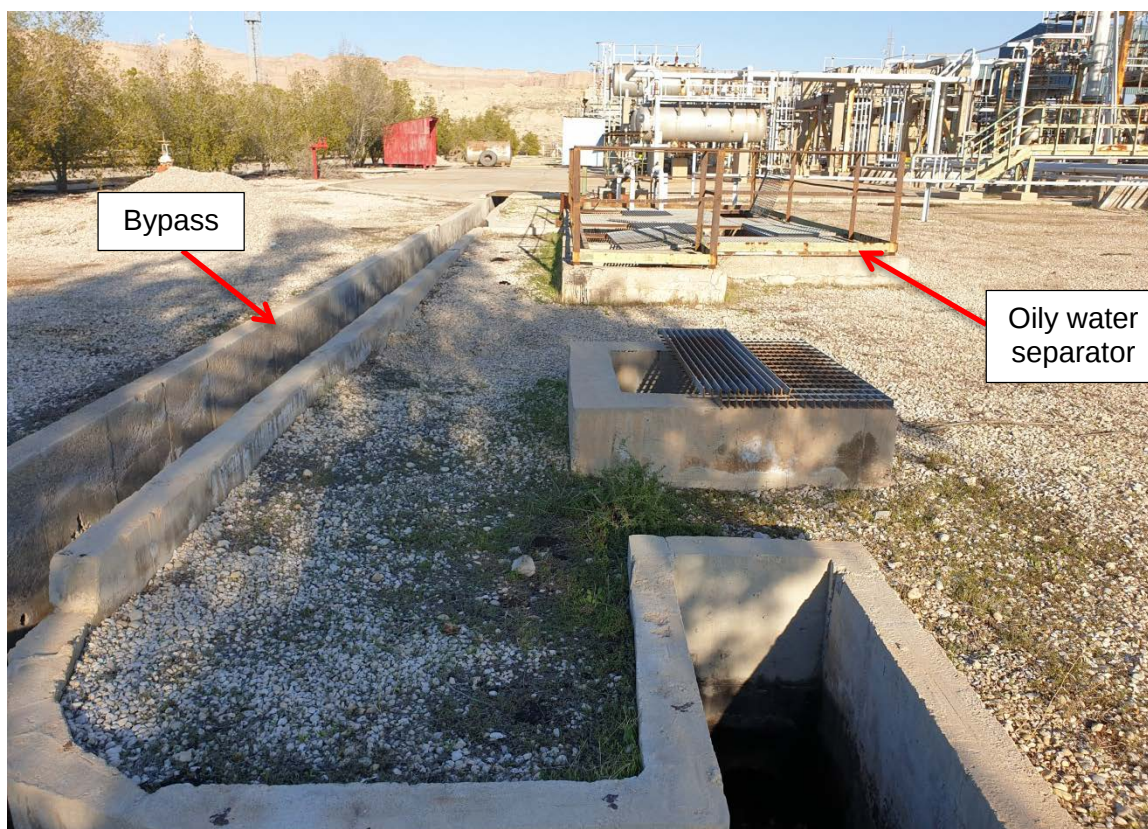
سیستم Oily water separator و بایپس
