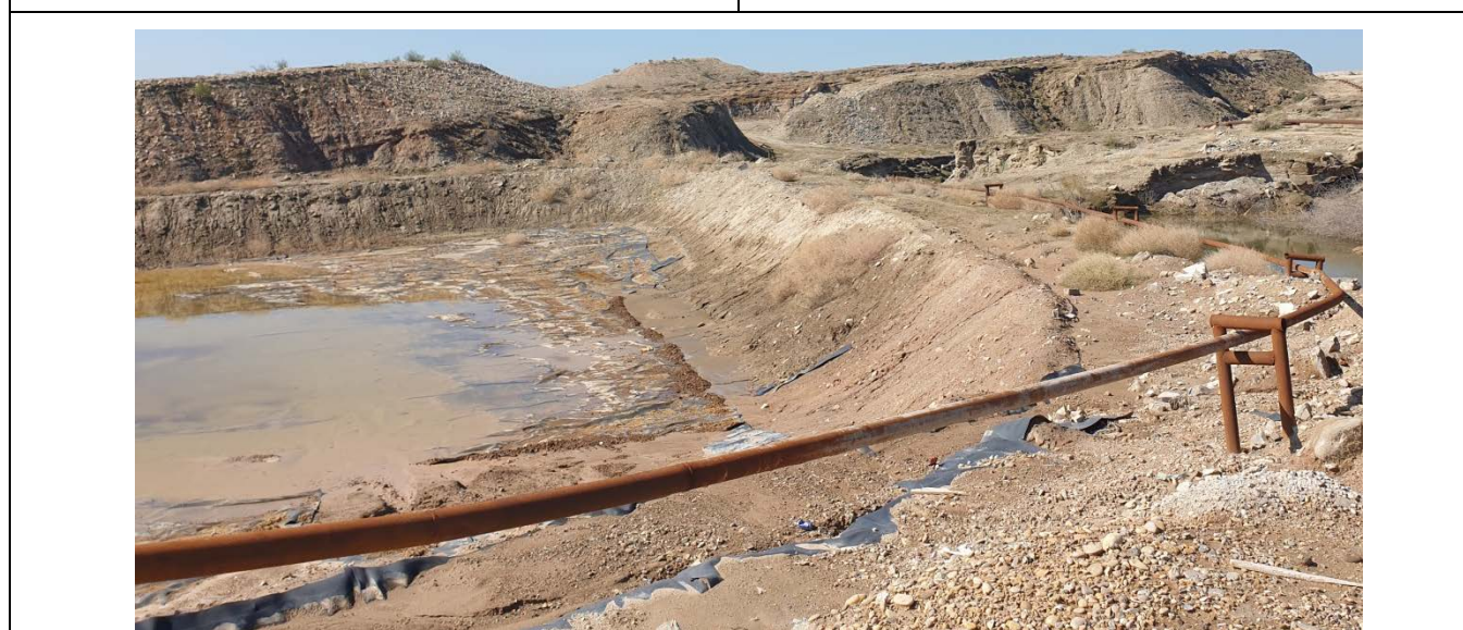
نمایی از جاده دسترسی پیرامون گودال و لایه ژئوممبران- عبور خط لوله گودال سوخت از کنار جاده دسترسی گودال
