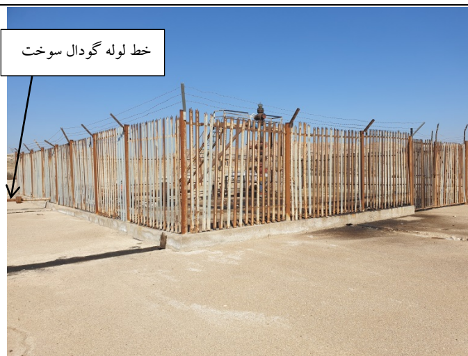
نمایی از فنس و محل خروج خط لوله گودال سوخت
