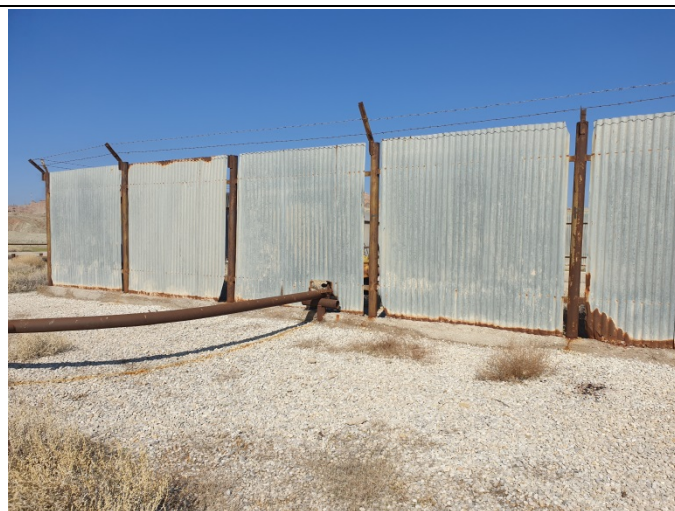
نمایی از فنس و محل خروج خط لوله گودال سوخت
