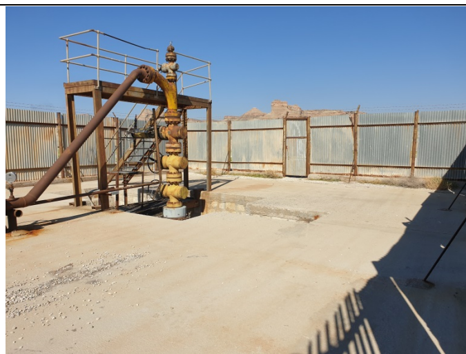
نمایی از محوطه داخل فنس و اطراف سلر چاه تعمیراتی BK12
