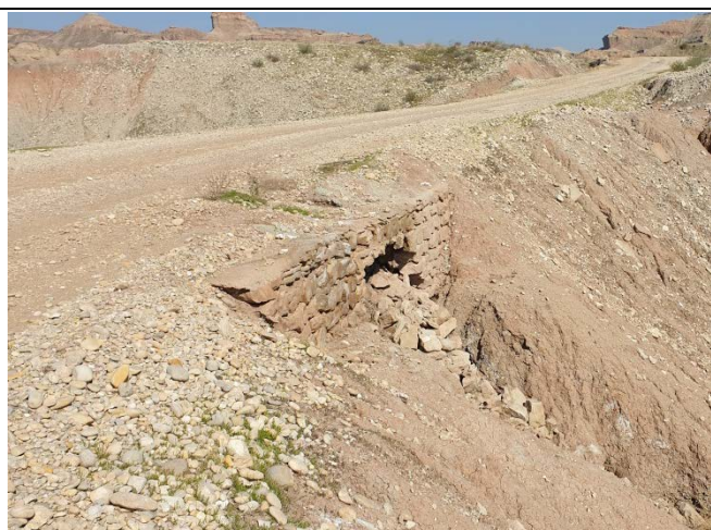
نمایی از وضعیت نامناسب کالورت
