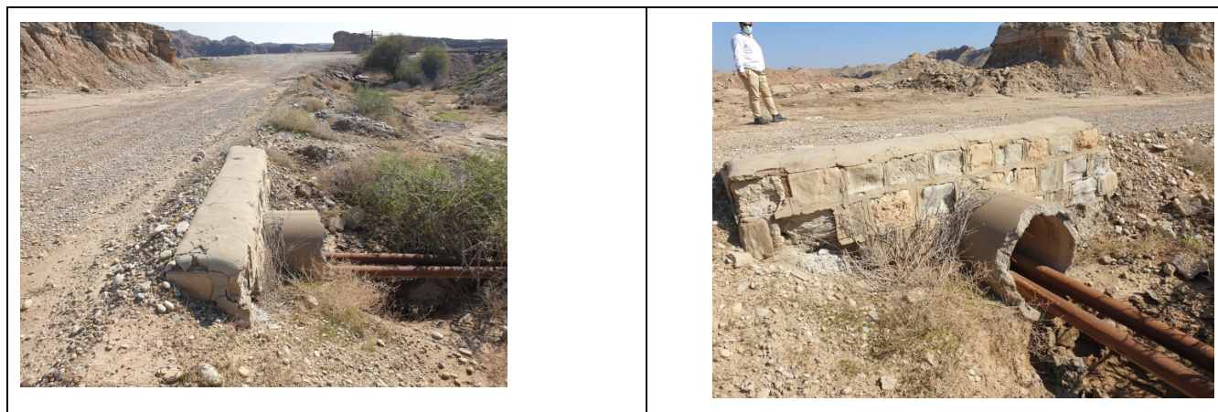
خط لوله نفت روزمینی چاه BK5 و محل تقاطع با جاده دسترسی (کیلومتر 3+036)
