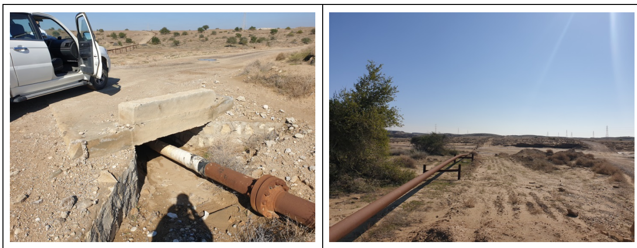
خط لوله نفت روزمینی و محل تقاطع با جاده دسترسی (کیلومتر 850+0)
