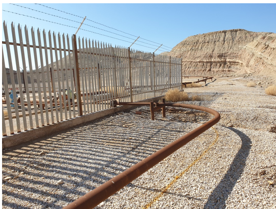
محل خروج لوله های خط جریانی و خط لوله گودال سوخت از محدوده فنس
