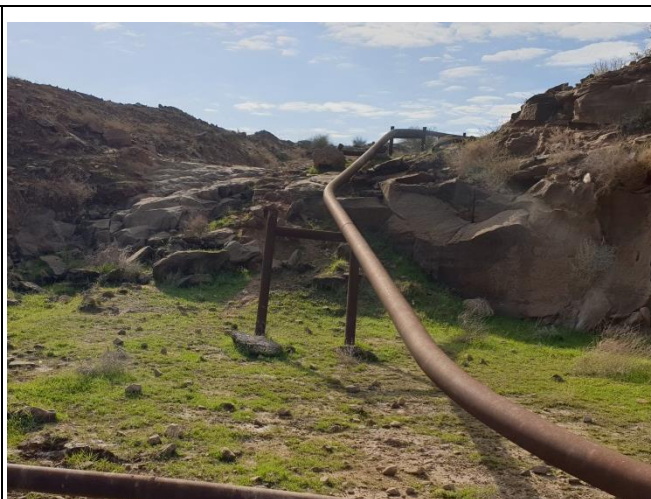
وضعیت نامناسب دو عدد از ساپورت های خط لوله جریانی
