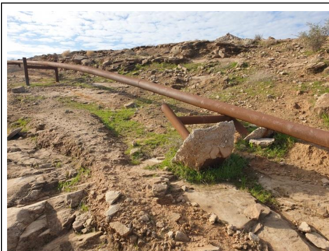
وضعیت نامناسب دو عدد از ساپورت های خط لوله جریانی
