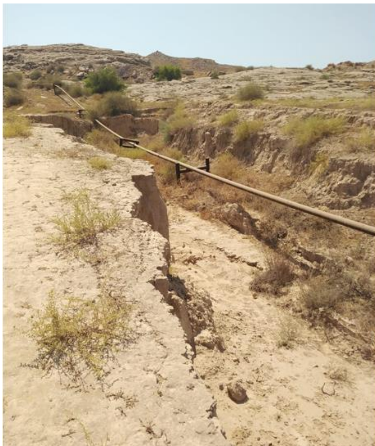
خط لوله گودال سوخت (در خط القعر قرار گرفته) و جاده دسترسی گودال سوخت که تخریب شده است.
