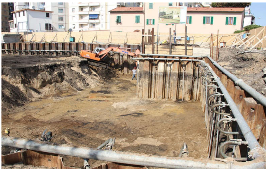
شکل 7-4- سیستم آبکشی با نقطه چاه
