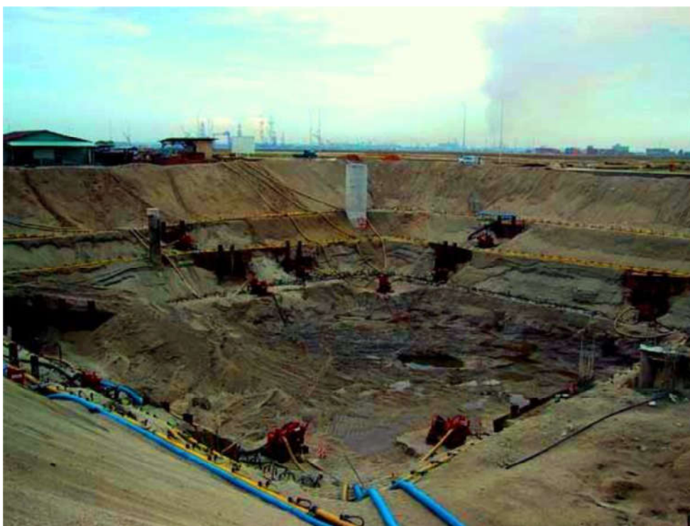
شکل 5-7- سیستم نقطه چاه چند مرحله‌ای
