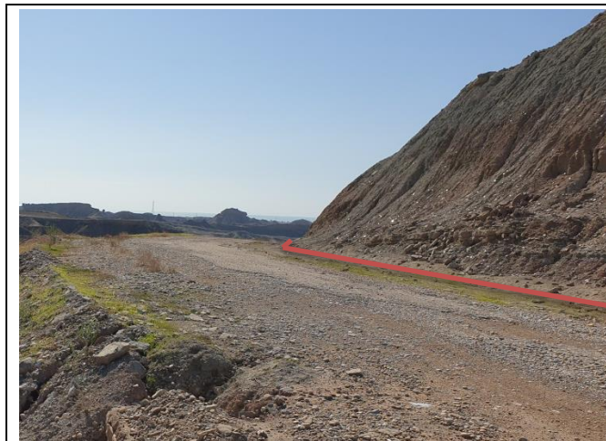
نمایی از جاده دسترسی به سمت مسیر بندرگناوه-دیلیم نیاز به تعبیه کانال هدایت جریان در سمت ارتفاعات
