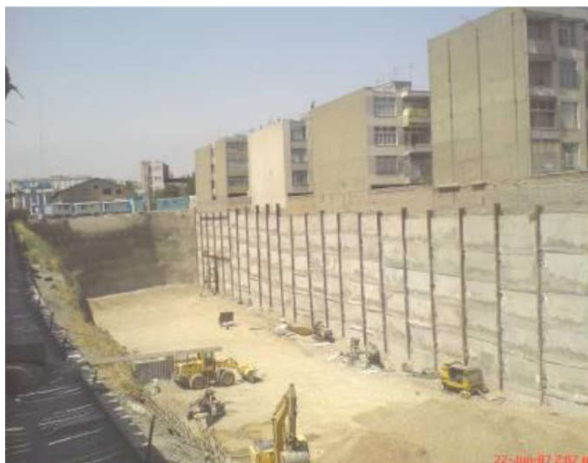
شکل 7-2 - تصاویری از سازه های نگهدارنده جهت گودبرداری (روش نیلینگ و دیوار برلنی)
