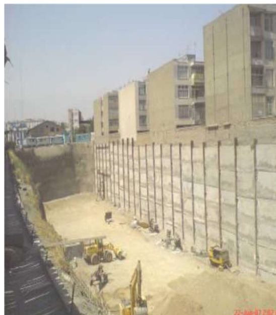
شکل 7-2 - تصاویری از سازه های نگهدارنده جهت گودبرداری (روش نیلینگ و دیوار برلنی)
