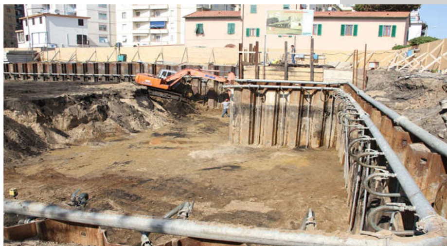
شکل 4-7 - سیستم آبکشی با نقطه چاه
