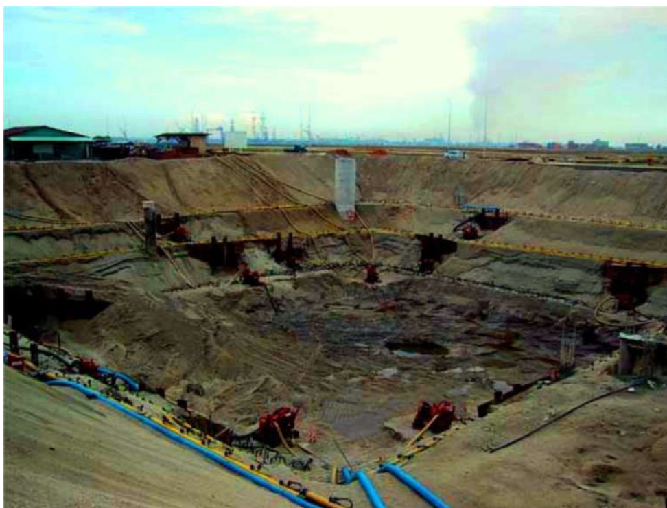
شکل 5-7 - سیستم نقطه چاه چند مرحله‌ای
