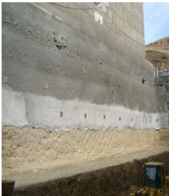
شکل 7-2 - تصاویری از سازه های نگهدارنده جهت گودبرداری (روش نیلینگ و دیوار برلنی)
