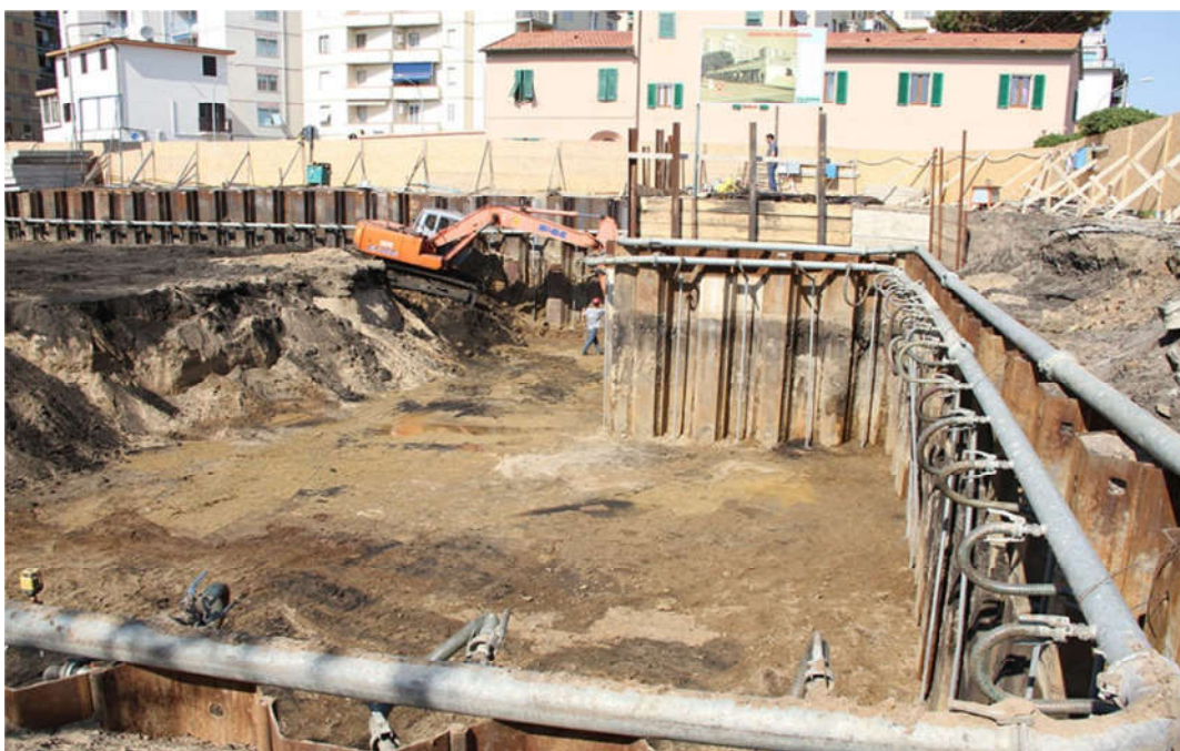
شکل 4-7 - سیستم آبکشی با نقطه چاه
