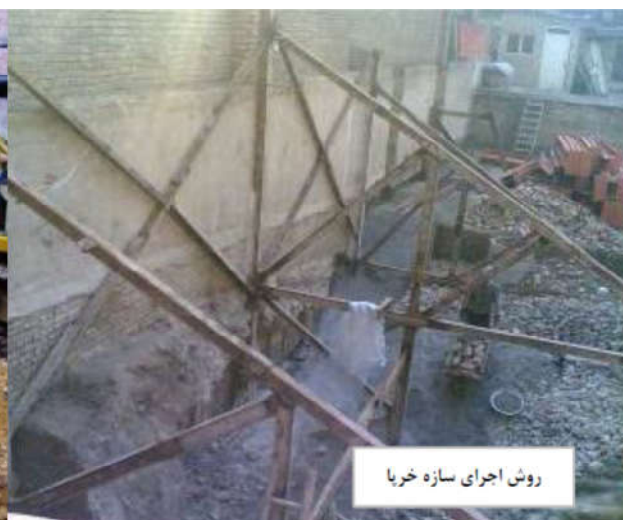
شکل 1-7 - تصاویری از سازه های نگهدارنده جهت گودبرداری (روش اجرای شمع و خریا)
