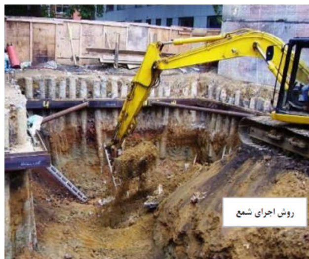
شکل 1-7 - تصاویری از سازه های نگهدارنده جهت گودبرداری (روش اجرای شمع و خریا)
