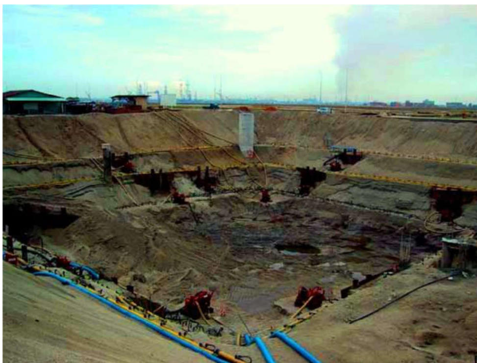
شکل 5-7 - سیستم نقطه چاه چند مرحله ای
