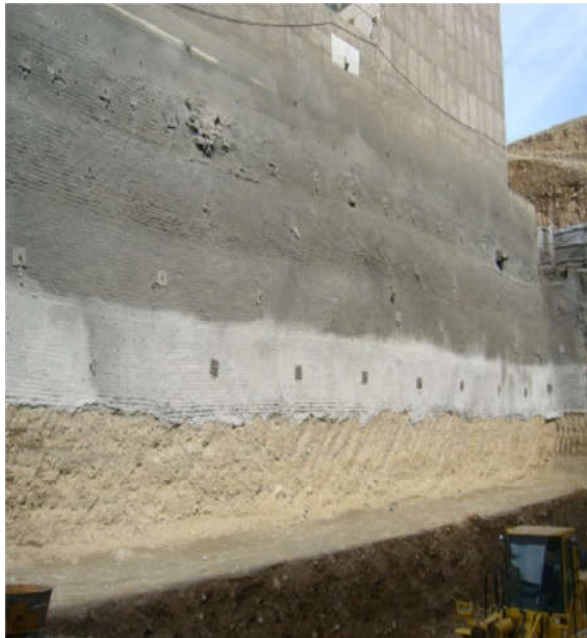
شکل 7-1 - تصاویری از سازه های نگهدارنده جهت گودبرداری (روش نیلینگ و دیوار برلنی)
