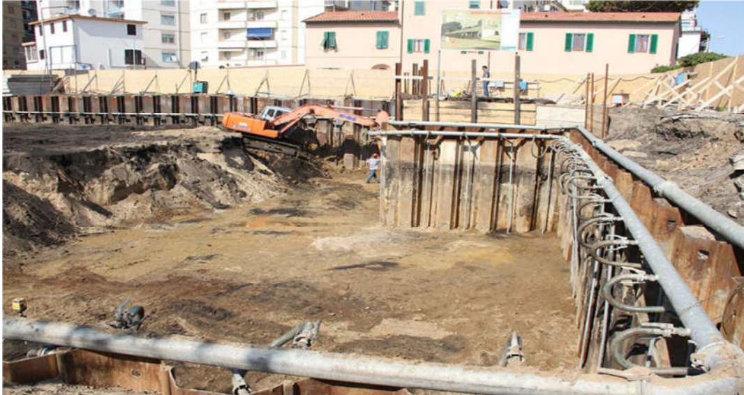
شکل 7-3 - سیستم آبکشی با نقطه چاه
