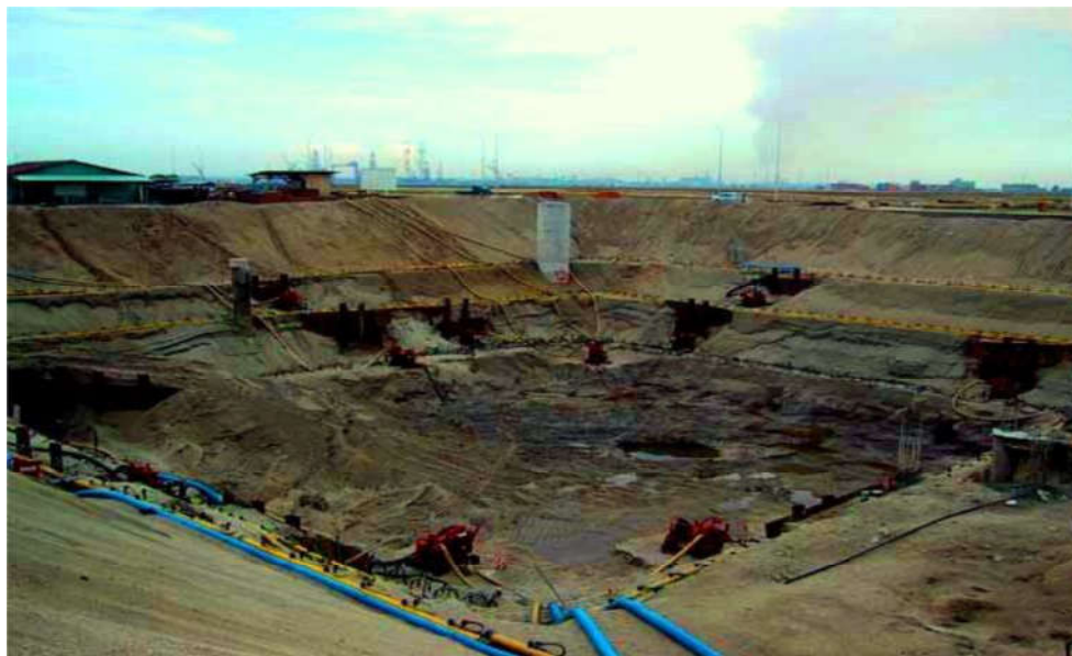
شکل 7-4 - سیستم نقطه چاه چند مرحله ای
