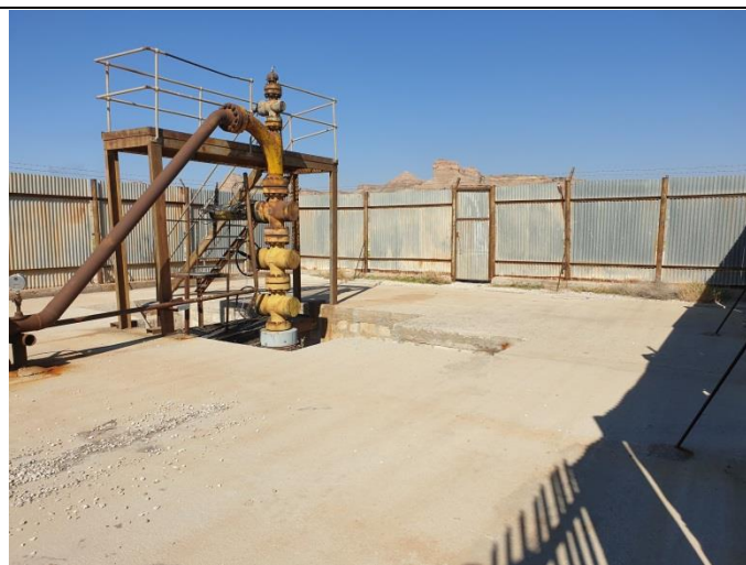
نمایی از محوطه داخل فنس و اطراف سلر چاه تعمیراتی BK12
