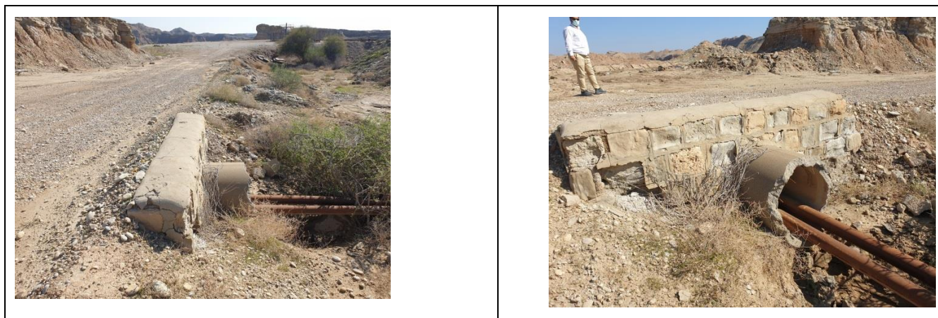
خط لوله نفت روزمینی چاه BK5 و محل تقاطع با جاده دسترسی (کیلومتر ۳+۰۳۶)
