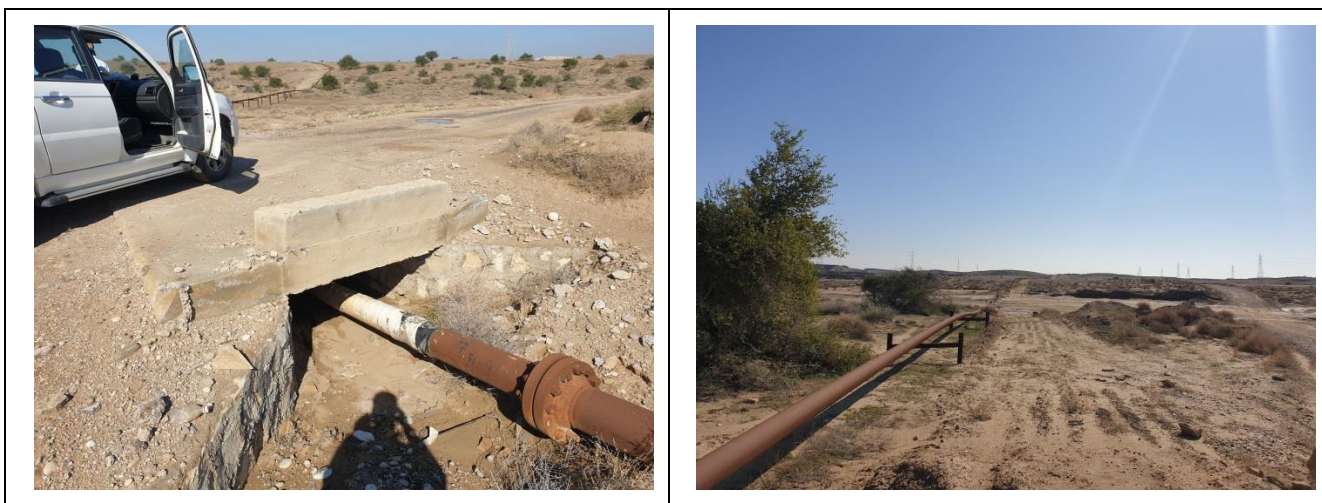
خط لوله نفت روزمینی و محل تقاطع با جاده دسترسی (کیلومتر ۸۵۰+۰)
