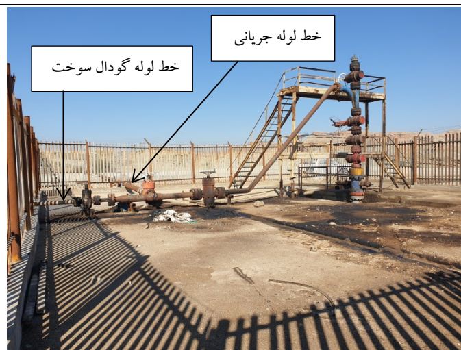
نمایی از محوطه داخل فنس و اطراف سِر چاه تعمیراتی BK05
