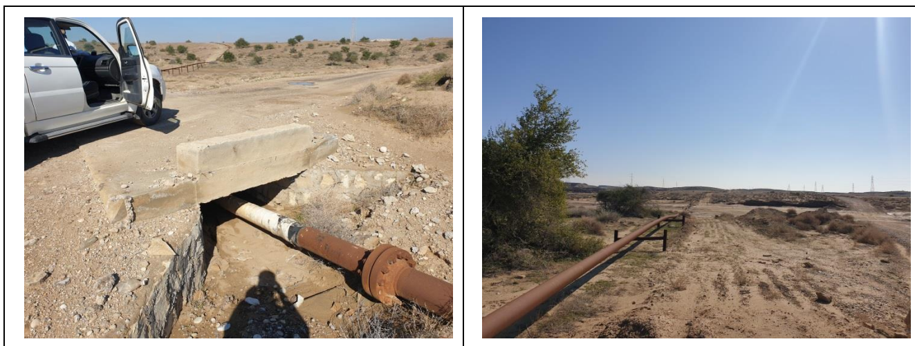
خط لوله نفت روزمینی و محل تقاطع با جاده دسترسی (کیلومتر ۰+۸۵۰)
