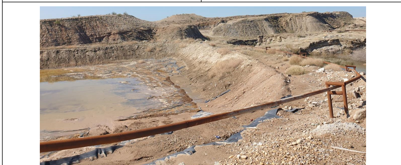
نمایی از جاده دسترسی پیرامون گودال و لایه ژئوممبران- عبور خط لوله گودال سوخت از کنار جاده دسترسی گودال
