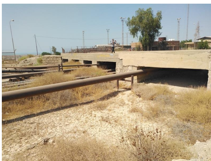
کریدور خطوط جریانی ورودی و پل احداث شده برای عبور خطوط
