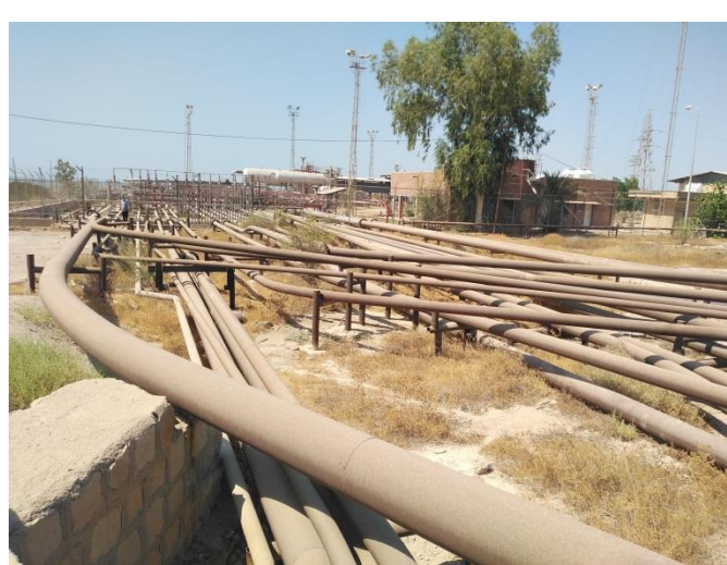
کریدور خطوط جریانی ورودی و پل احداث شده برای عبور خطوط
