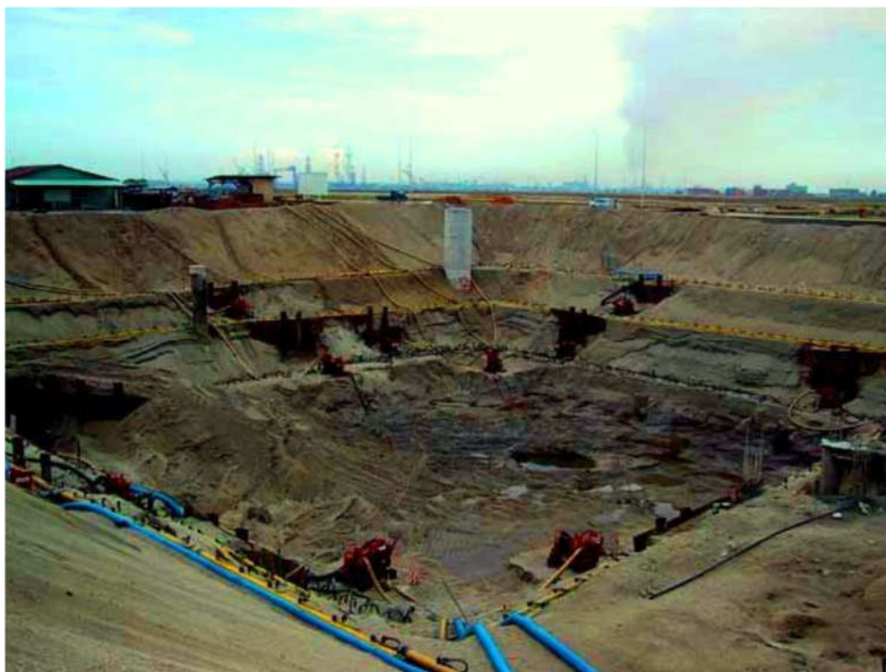
شکل 7-5- سیستم نقطه چاه چند مرحله‌ای
