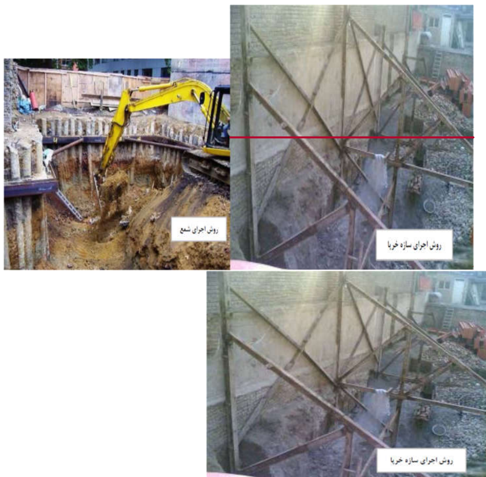
شکل 7-1- تصاویری از سازه های نگهدارنده جهت گودبرداری (روش اجرای شمع و خربا)
