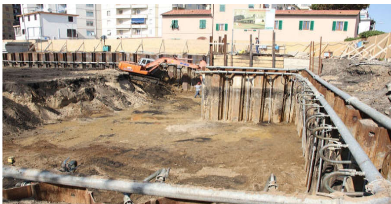
شکل 7-4- سیستم آبکشی با نقطه چاه
