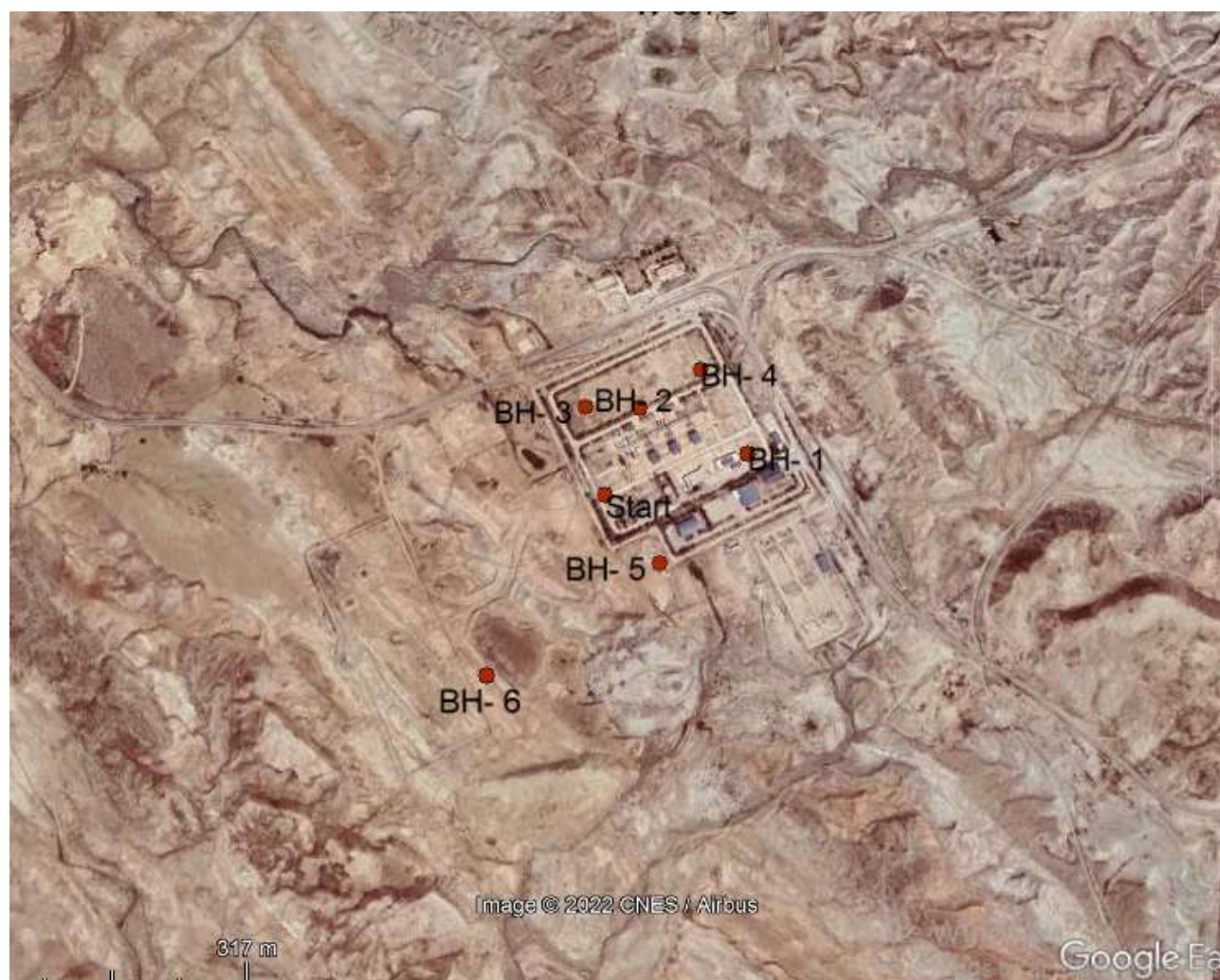
شکل ۴-۱- ایستگاه تقویت فشار
