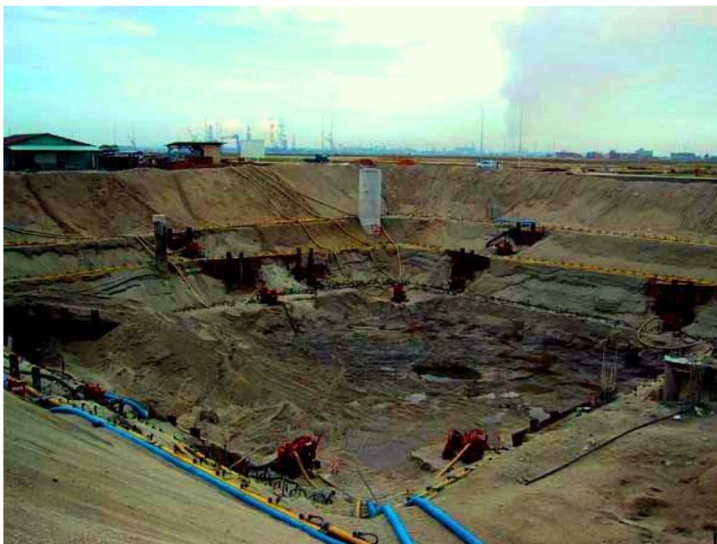
شکل ۷-۴ - سیستم نقطه چاه چند مرحله‌ای
