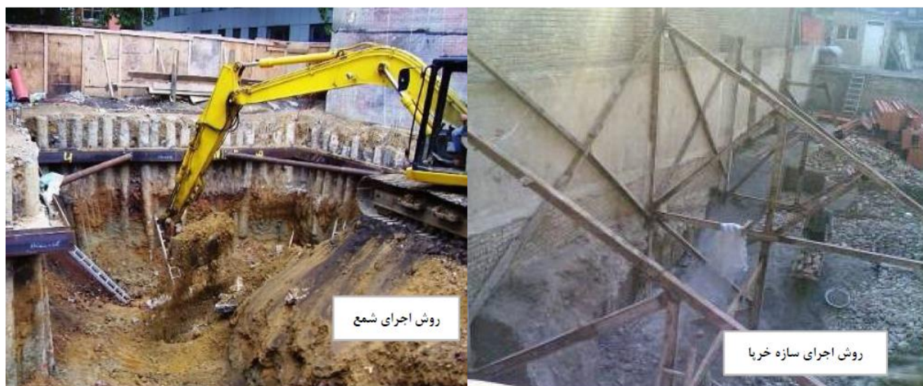
شکل ۷-۱ - تصاویری از سازه های نگهدارنده جهت گودبرداری (روش اجرای شمع و خرپا)
