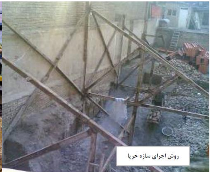
شکل ۷-۱ - تصاویری از سازه های نگهدارنده جهت گودبرداری (روش اجرای شمع و خرپا)
