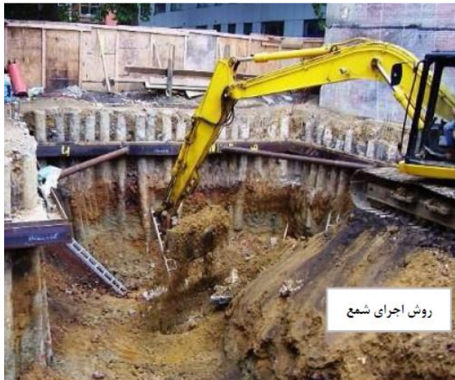
شکل ۷-۱ - تصاویری از سازه های نگهدارنده جهت گودبرداری (روش اجرای شمع و خرپا)
