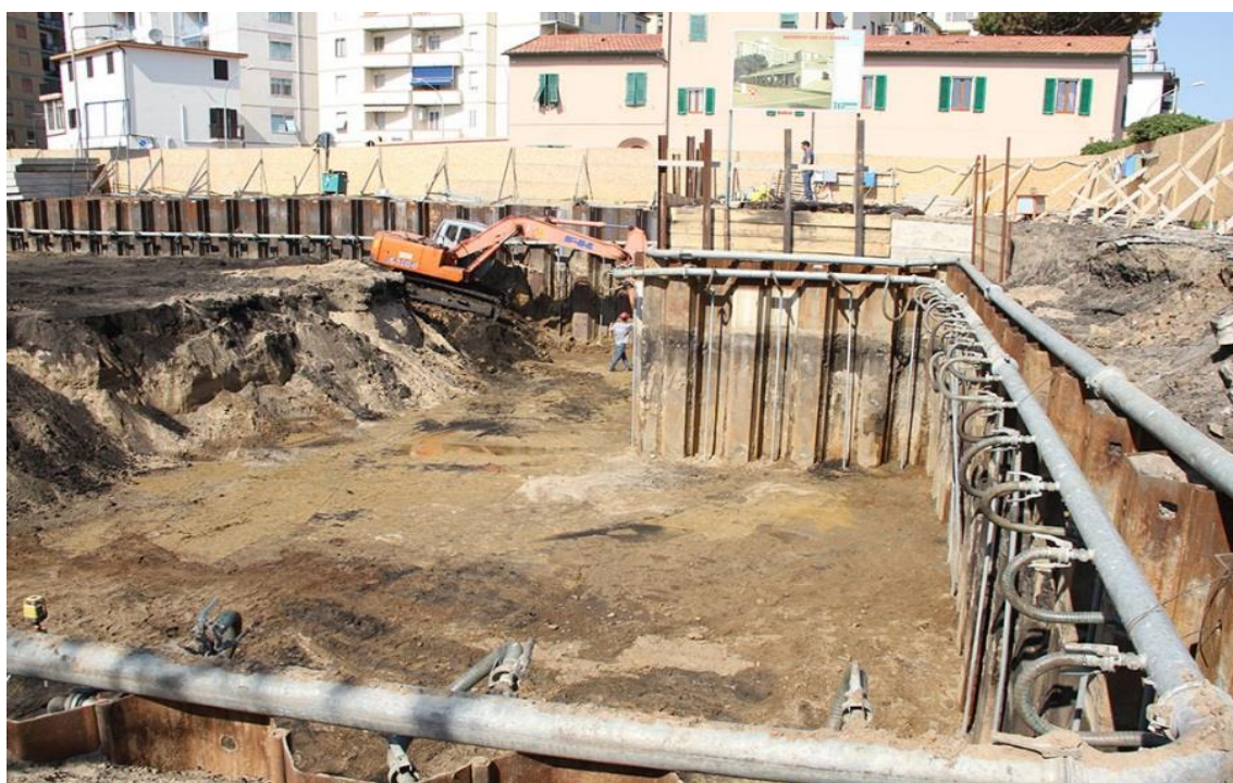
شکل ۷-۴ - سیستم آبکشی با نقطه چاه
