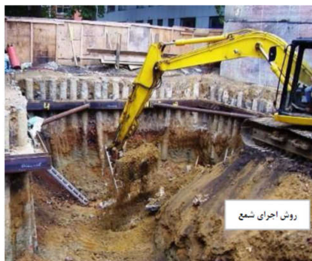
شکل 1-7 - تصاویری از سازه های نگهدارنده جهت گودبرداری (روش اجرای شمع و خرپا)
