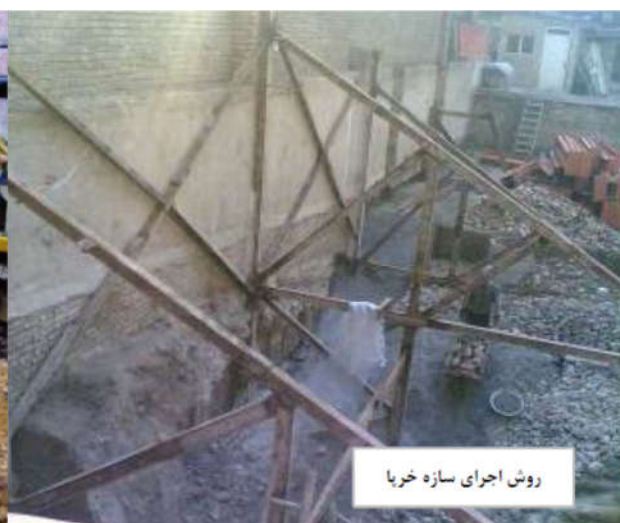
شکل 1-7 - تصاویری از سازه های نگهدارنده جهت گودبرداری (روش اجرای شمع و خرپا)
