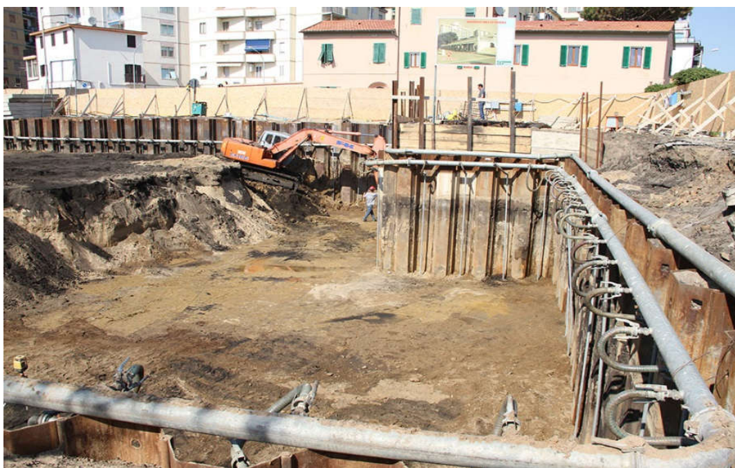
شکل 4-7- سیستم آبکشی با نقطه چاه
