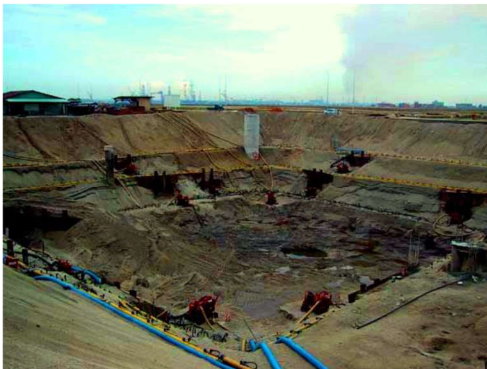
شکل 7-5- سیستم نقطه چاه چند مرحله ای
