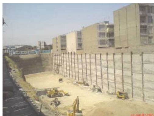
شکل 7-1 - تصاویری از سازه های نگهدارنده جهت گودبرداری (روش نیلینگ و دیوار برلنی)
