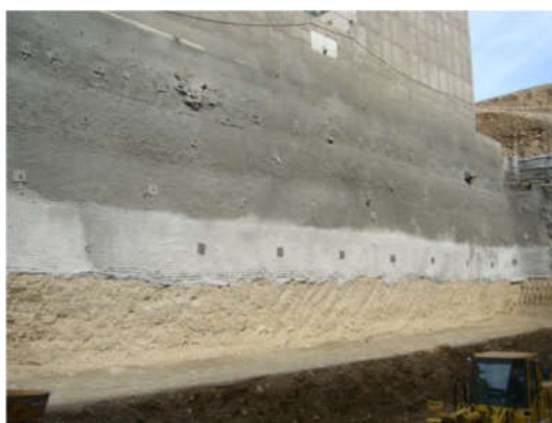
شکل 7-1 - تصاویری از سازه های نگهدارنده جهت گودبرداری (روش نیلینگ و دیوار برلنی)
