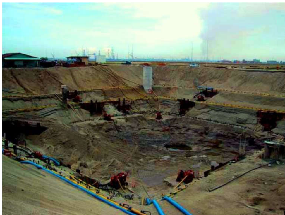
شکل 7-1 - سیستم نقطه چاه چند مرحله‌ای
