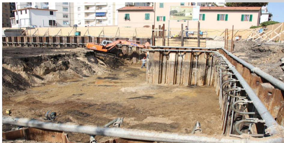
شکل 7-3 - سیستم آبکشی با نقطه چاه
