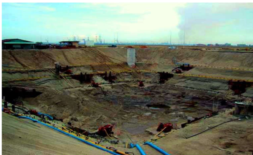
شکل 7-4 - سیستم نقطه چاه چند مرحله ای
