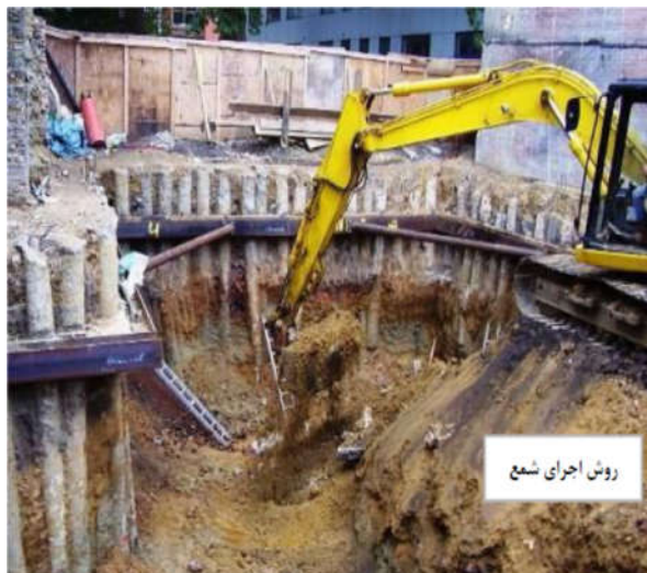
شکل 7-1- تصاویری از سازه های نگهدارنده جهت گودبرداری (روش اجرای شمع و خرپا)
