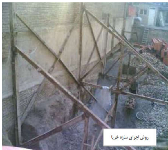
شکل 7-1- تصاویری از سازه های نگهدارنده جهت گودبرداری (روش اجرای شمع و خرپا)
