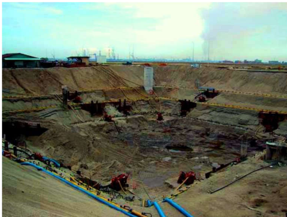
شکل 7-1 - سیستم نقطه چاه چند مرحله‌ای
