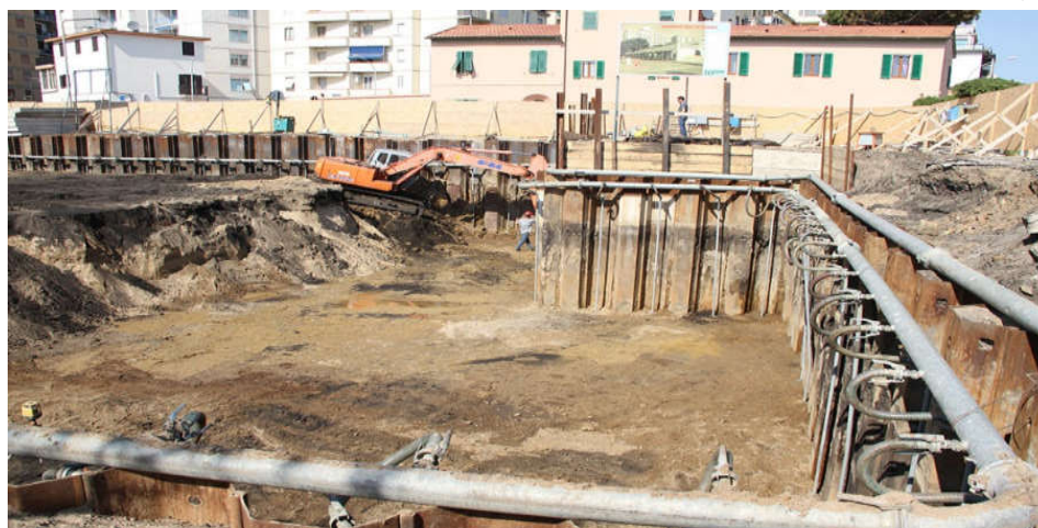
شکل 7-3 - سیستم آبکشی با نقطه چاه
