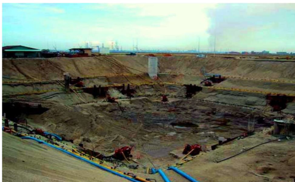
شکل 7-4 - سیستم نقطه چاه چند مرحله ای
