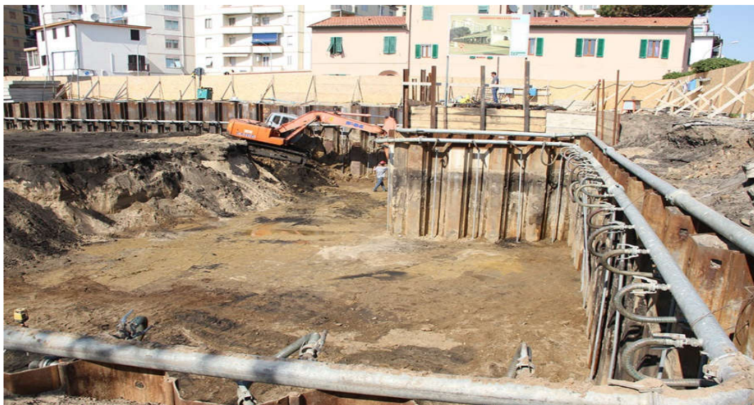
شکل 7-3 - سیستم آبکشی با نقطه چاه
