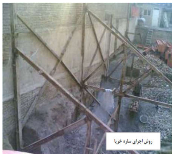
شکل 7-1- تصاویری از سازه های نگهدارنده جهت گودبرداری (روش اجرای شمع و خربا)
