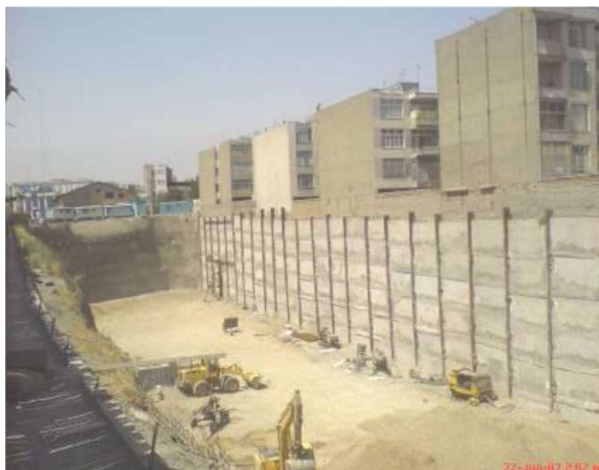
شکل 2-7 - تصاویری از سازه های نگهدارنده جهت گودبرداری (روش نیلینگ و دیوار برلنی)
