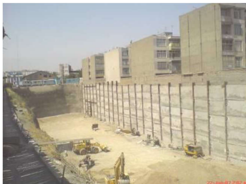
شکل 2-7 - تصاویری از سازه های نگهدارنده جهت گودبرداری (روش نیلینگ و دیوار برلنی)
