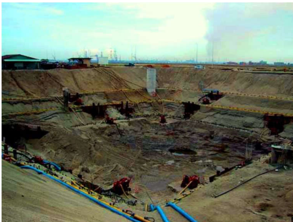
شکل 7-4 - سیستم نقطه چاه چند مرحله ای
