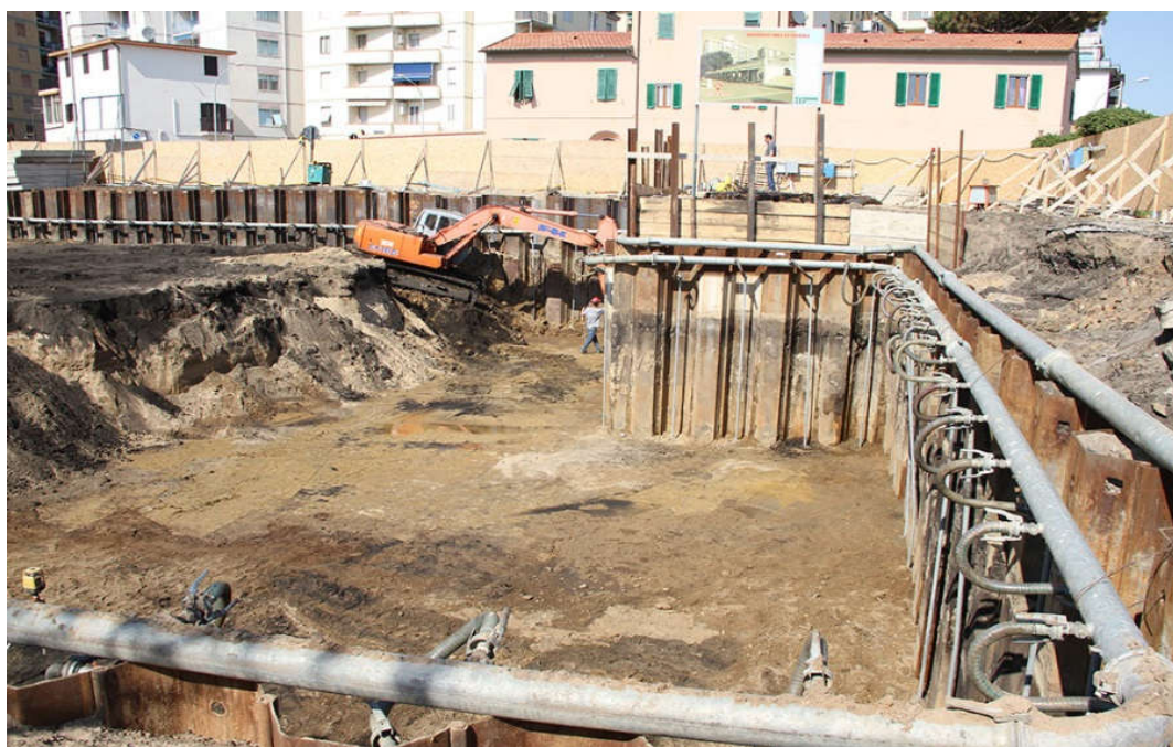
شکل 7-3 - سیستم آبکشی با نقطه چاه
