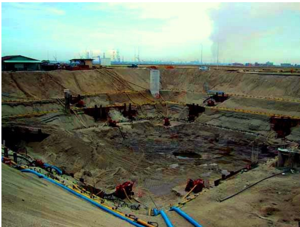
شکل ۷-۴ - سیستم نقطه چاه چند مرحله‌ای
