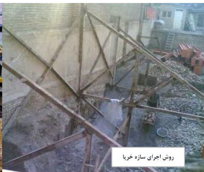
شکل ۷-۱- تصاویری از سازه‌های نگهدارنده جهت گودبرداری (روش اجرای شمع و خریا)
