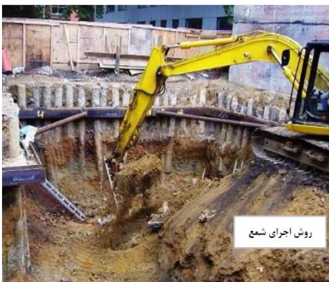
شکل ۷-۱- تصاویری از سازه‌های نگهدارنده جهت گودبرداری (روش اجرای شمع و خریا)
