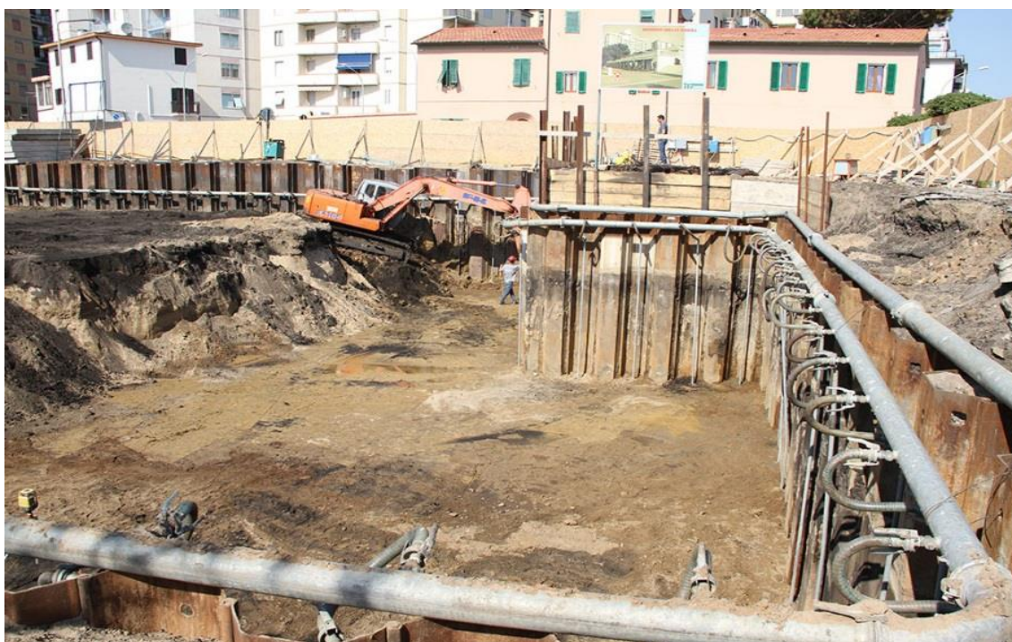
شکل ۷-۳ - سیستم آبکشی با نقطه چاه
