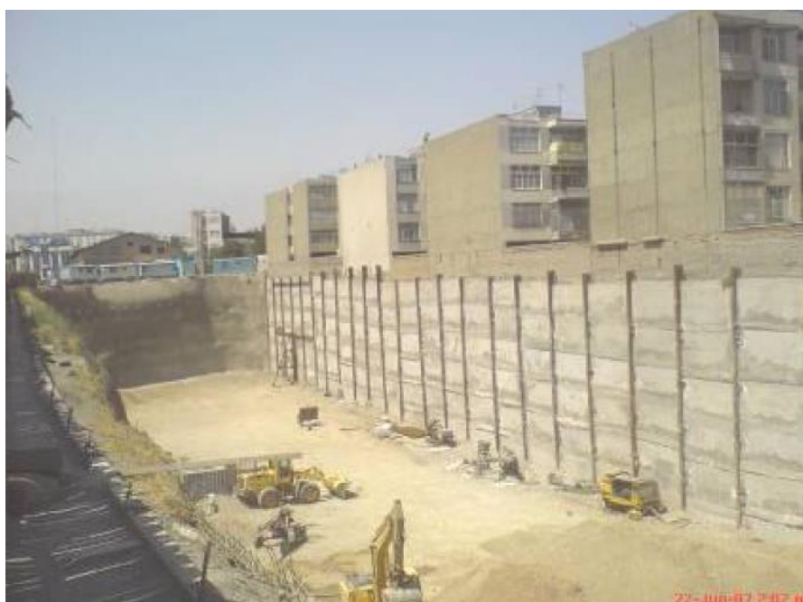
شکل ۱-۷ - تصاویری از سازه های نگهدارنده جهت گودبرداری (روش نیلینگ و دیوار برلنی)
