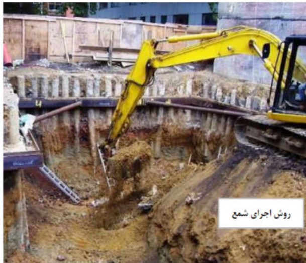
شکل 7-1 - تصاویری از سازه های نگهدارنده جهت گودبرداری (روش اجرای شمع و خرپا)
