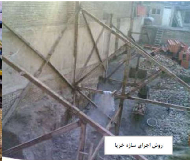
شکل 7-1 - تصاویری از سازه های نگهدارنده جهت گودبرداری (روش اجرای شمع و خرپا)
