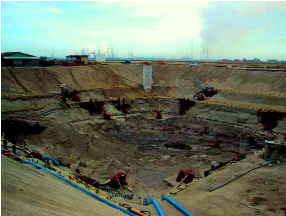
شکل 5-7 - سیستم نقطه چاه چند مرحله‌ای
