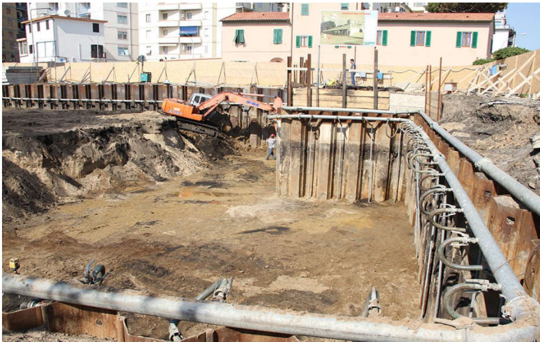
شکل 4-7 - سیستم آبکشی با نقطه چاه
