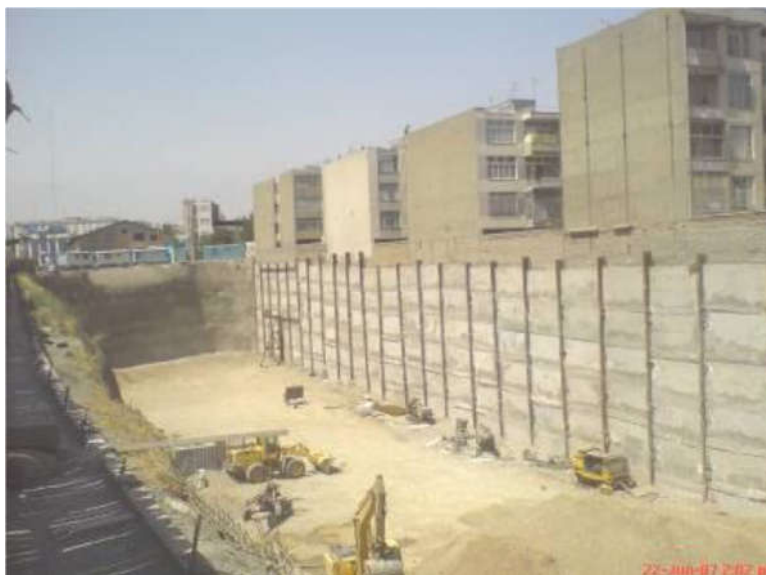
شکل 7-2 - تصاویری از سازه های نگهدارنده جهت گودبرداری (روش نیلینگ و دیوار برلنی)
