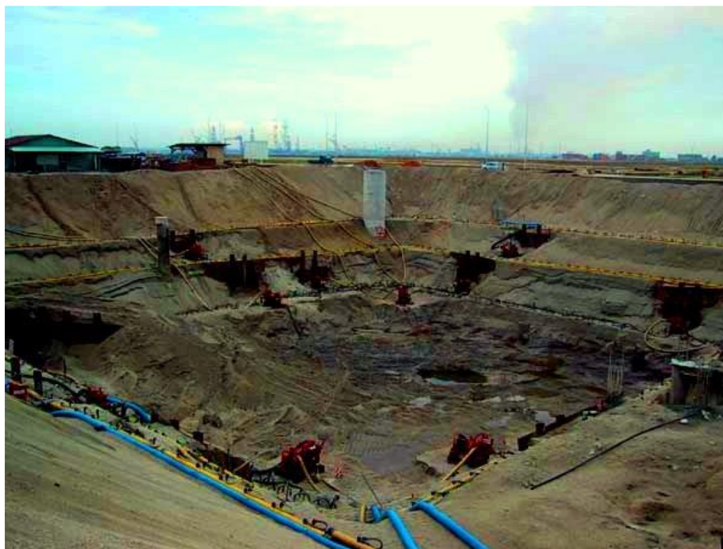
شکل ۷-۵- سیستم نقطه چاه چند مرحله‌ای
