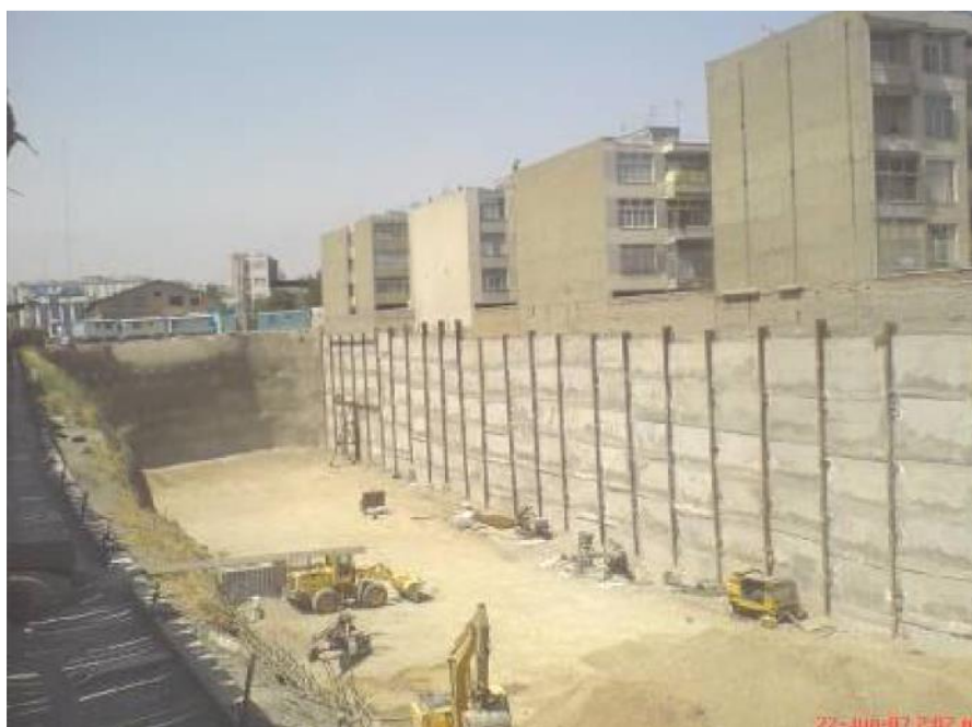
شکل ۷-۲ - تصاویری از سازه های نگهدارنده جهت گودبرداری (روش نیلینگ و دیوار برلنی)
