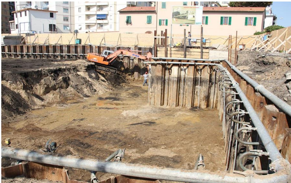
شکل ۷-۴- سیستم آبکشی با نقطه چاه
