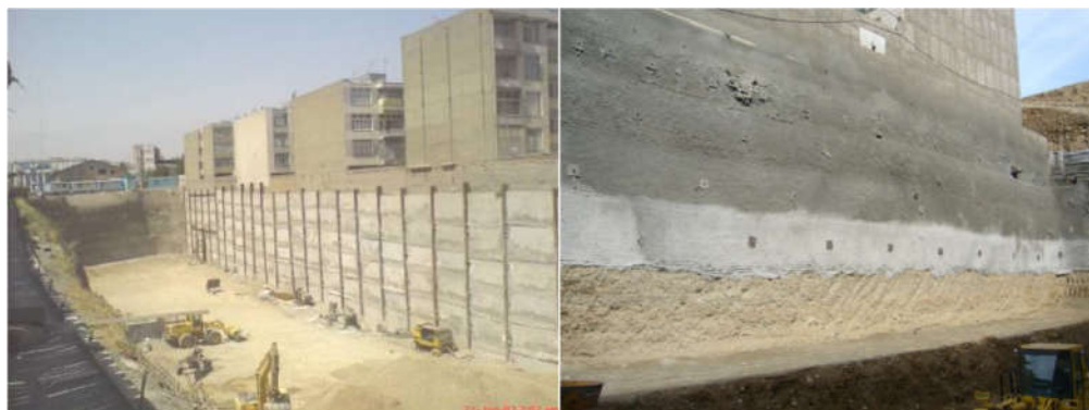
شکل 7-1 - تصاویری از سازه های نگهدارنده جهت گودبرداری (روش نیلینگ و دیوار برنی)
