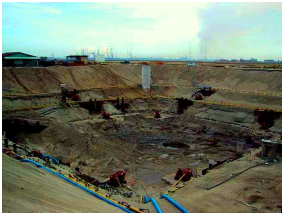
شکل 7-1 - سیستم نقطه چاه چند مرحله‌ای
