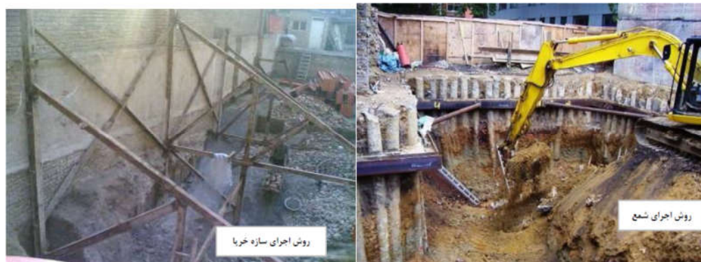
شکل 7-1- تصاویری از سازه های نگهدارنده جهت گودبرداری (روش اجرای شمع و خرپا)
