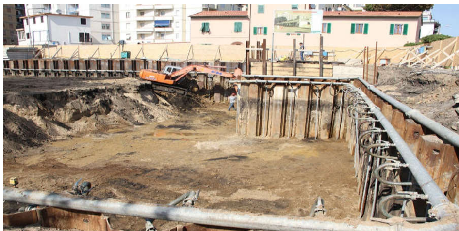
شکل 7-3 - سیستم آبکشی با نقطه چاه
