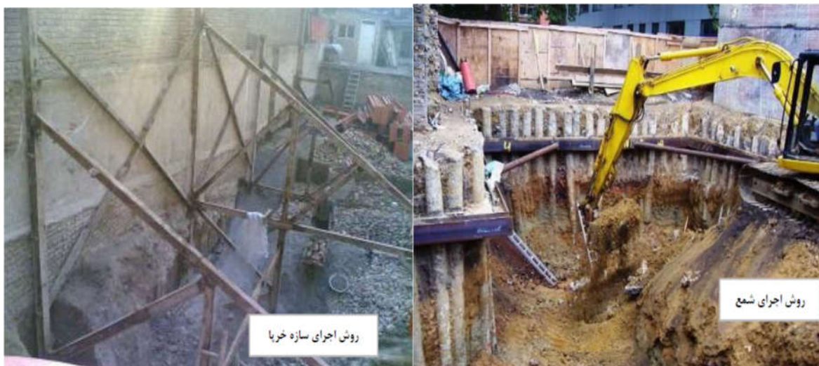
شکل 7-1- تصاویری از سازه های نگهدارنده جهت گودبرداری (روش اجرای شمع و خرپا)
