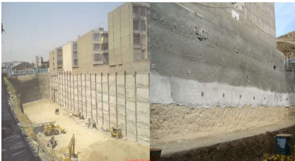
شکل 7-1 - تصاویری از سازه های نگهدارنده جهت گودبرداری (روش نیلینگ و دیوار برلنی)
