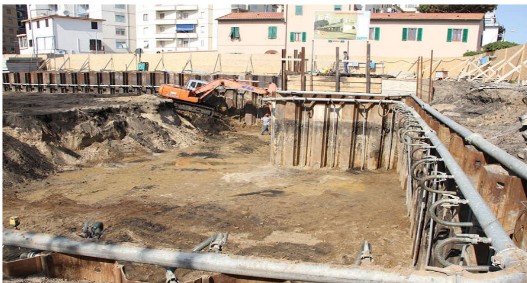
شکل 7-3 - سیستم آبکشی با نقطه چاه
