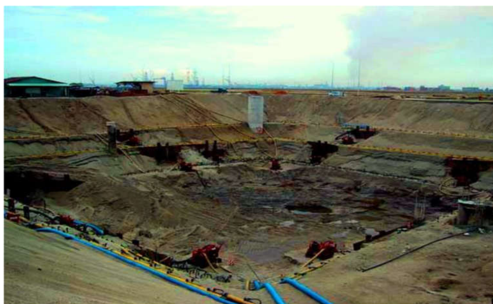
شکل 7-4 - سیستم نقطه چاه چند مرحله ای
