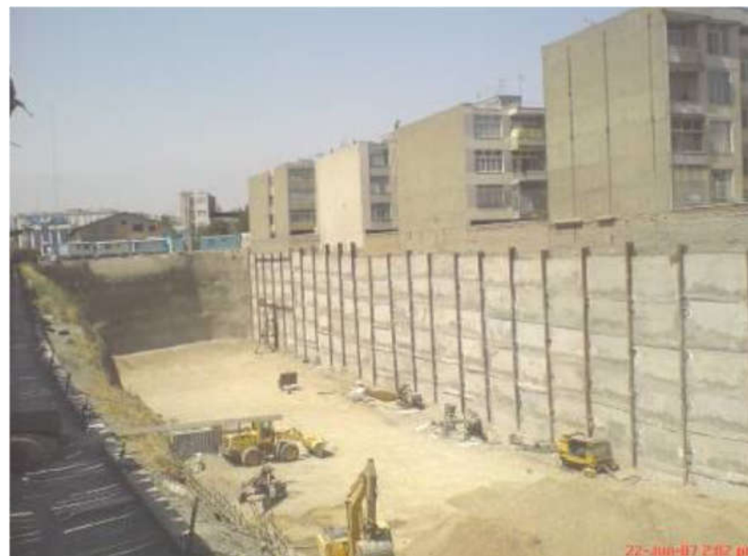
شکل 7-2 - تصاویری از سازه های نگهدارنده جهت گودبرداری (روش نیلینگ و دیوار برلنی)
