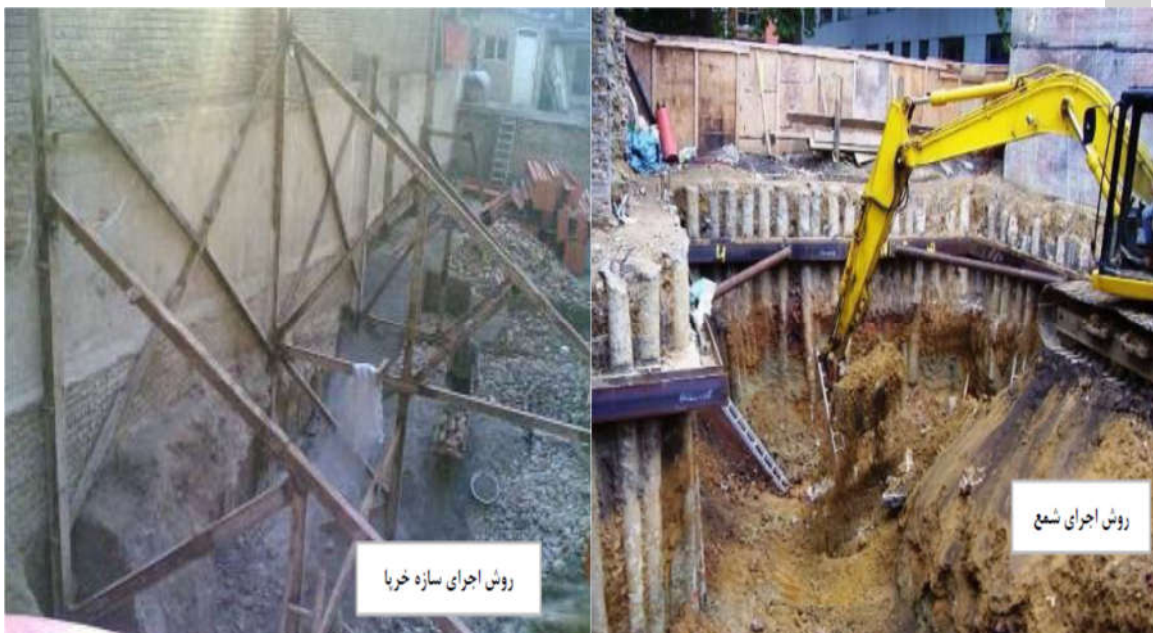
شکل 7-1- تصاویری از سازه های نگهدارنده جهت گودبرداری (روش اجرای شمع و خرپا)
