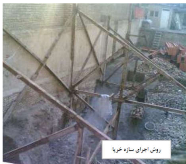
شکل 7-1- تصاویری از سازه های نگهدارنده جهت گودبرداری (روش اجرای شمع و خربا)
