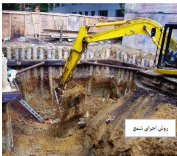
شکل 7-1- تصاویری از سازه های نگهدارنده جهت گودبرداری (روش اجرای شمع و خربا)
