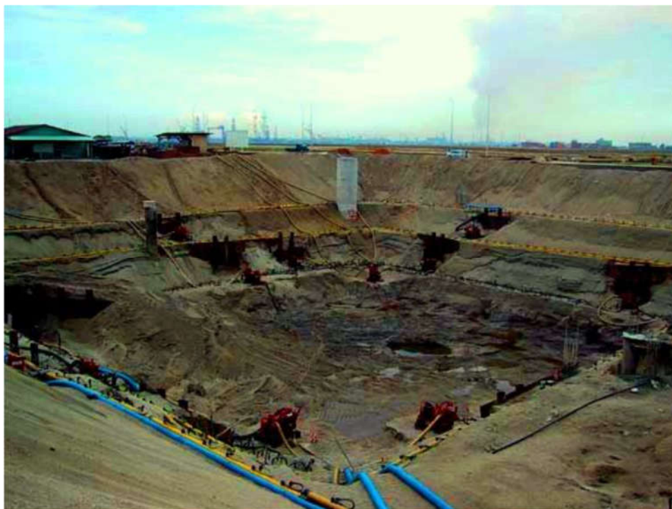
شکل 5-7 - سیستم نقطه چاه چند مرحله‌ای
