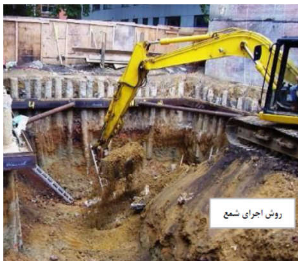
شکل 1-7 - تصاویری از سازه های نگهدارنده جهت گودبرداری (روش اجرای شمع و خریا)
