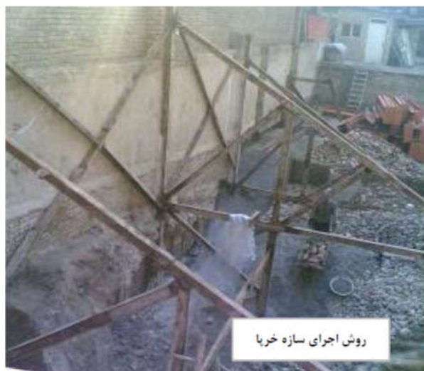
شکل 1-7 - تصاویری از سازه های نگهدارنده جهت گودبرداری (روش اجرای شمع و خریا)
