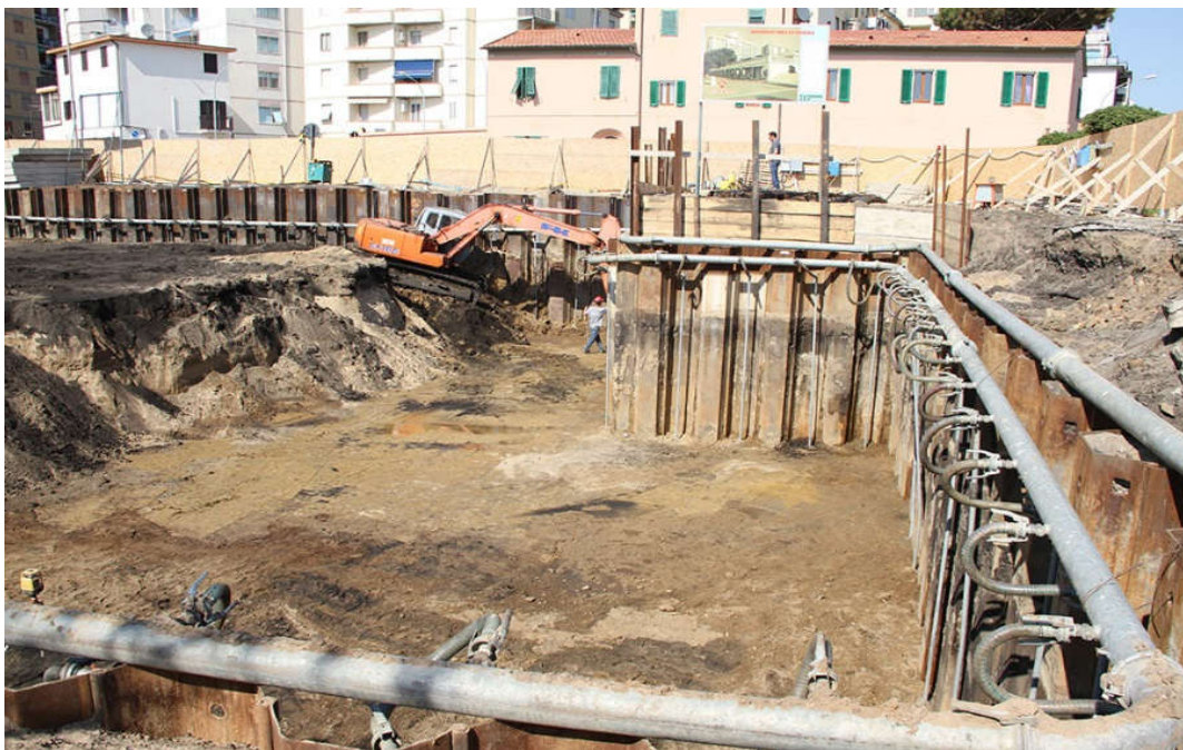
شکل 4-7- سیستم آبکشی با نقطه چاه
