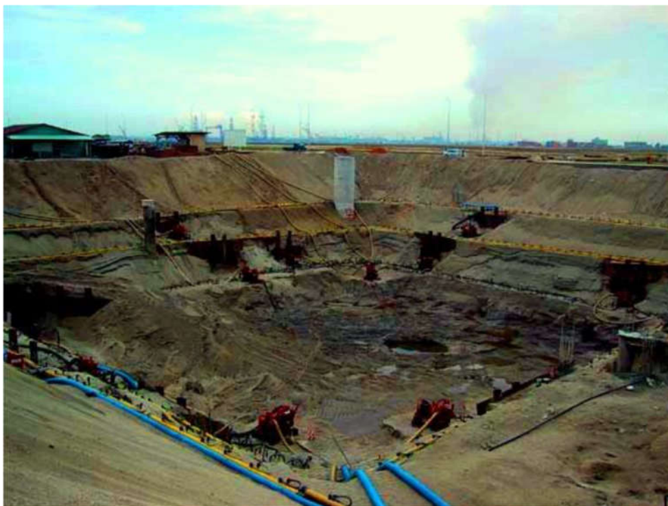
شکل 7-5- سیستم نقطه چاه چند مرحله ای
