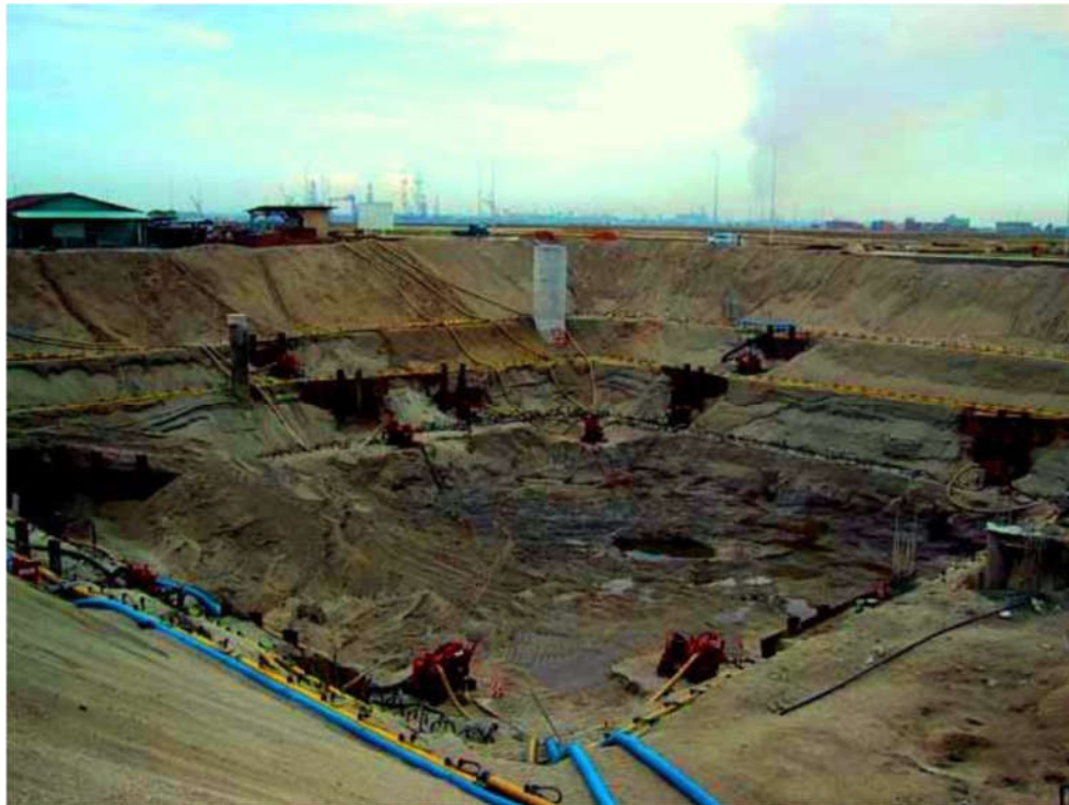
شکل 7-5- سیستم نقطه چاه چند مرحله‌ای
