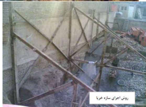
شکل 7-1- تصاویری از سازه های نگهدارنده جهت گودبرداری (روش اجرای شمع و خرپا)
