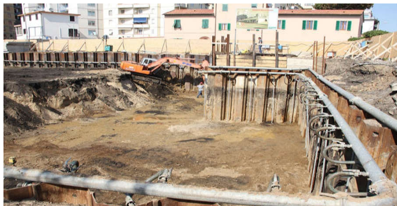
شکل 7-4- سیستم آبکشی با نقطه چاه
