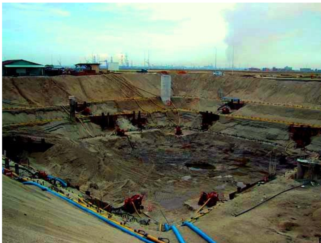
شکل ۷-۵- سیستم نقطه چاه چند مرحله‌ای
