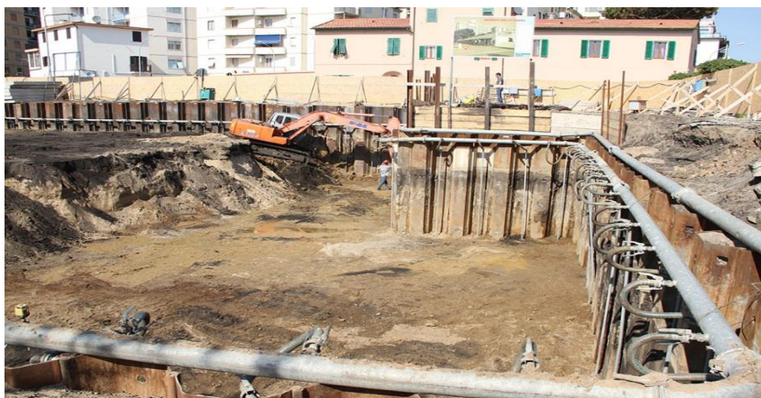
شکل ۷-۴- سیستم آبکشی با نقطه چاه
